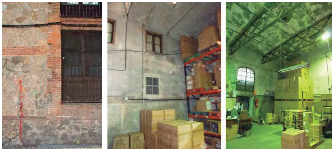
Interior de la Nau 1
