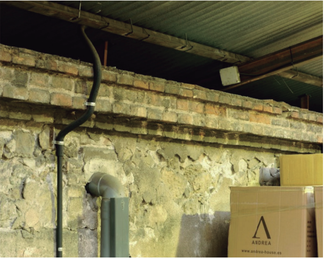
Detall de la cornissa nau lateral en la seva cara interior al pati central. Detall de la solució de coberta provisional
