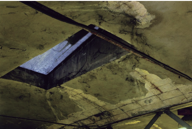
Detall d'una claraboia amb presència humitats i escrostonaments acabat
