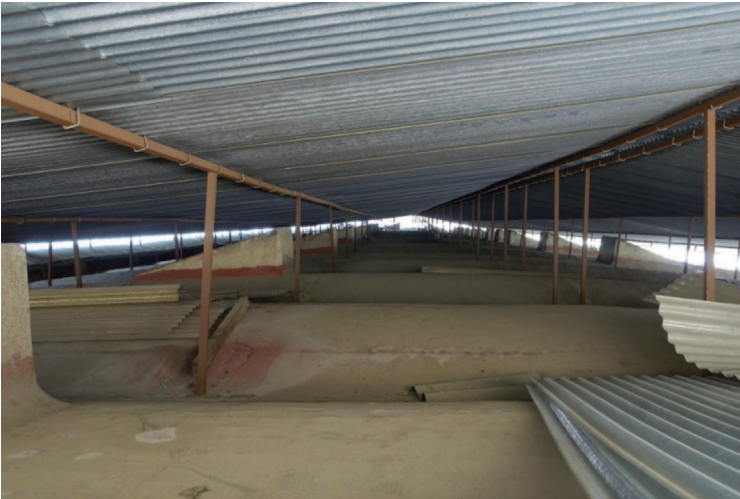
Visió superior de les voltes de mocador, amb acabat arrebossat i coberta provisional de protecció
