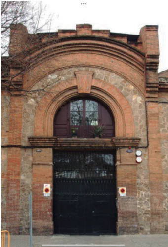
Portal accés central, amb configuració de doble columna i arc central, amb remat de cornissa corba i timpà escalonat amb merlets rematats amb peces ceràmiques.
