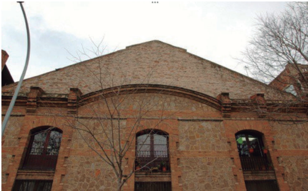
Detall del remat de la nau nord en la seva trobada en la façana principal, configurant un timpà reculad del plà de la façana per recollir la doble vessant de la coberta inclinada
