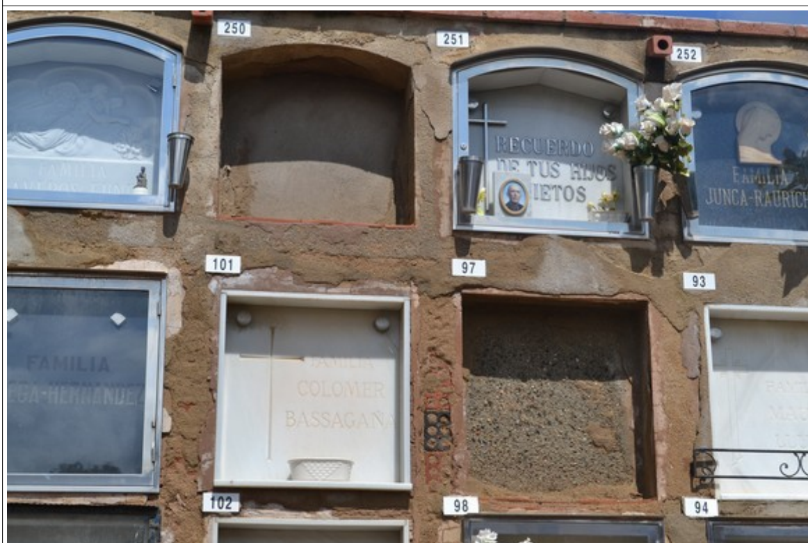
Escrostonaments i desprendiments de revestiment
