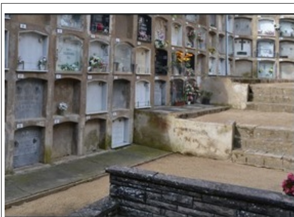
Vorera de formigó i part central sense pavimentar
