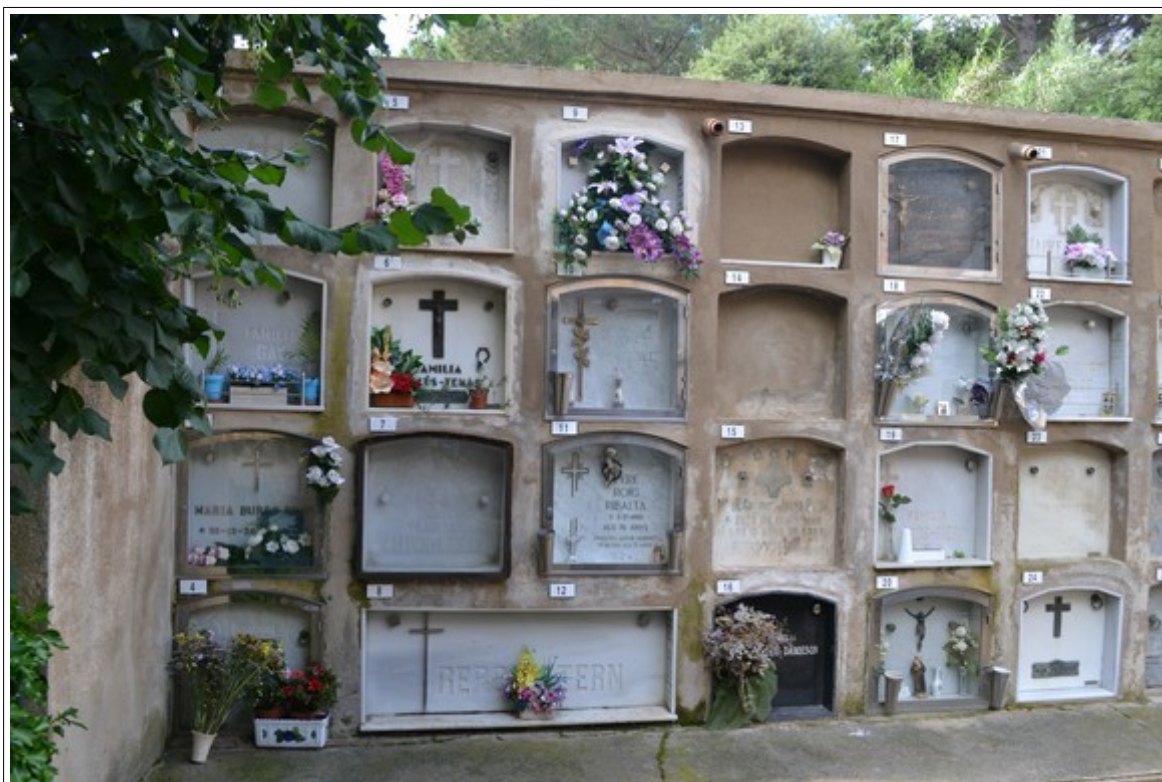
Humitat i verdet a la part inferior en revestiment envellit
