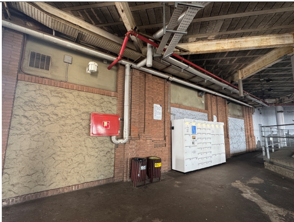
Vista exterior de les sortides de ventilació actuals (A conservar els punts de sortida)
