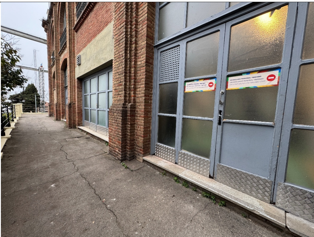
Pas exterior per accés al recinte
