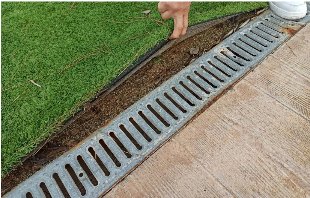
Imatge 6 Reixeta de recollida d'aigua
