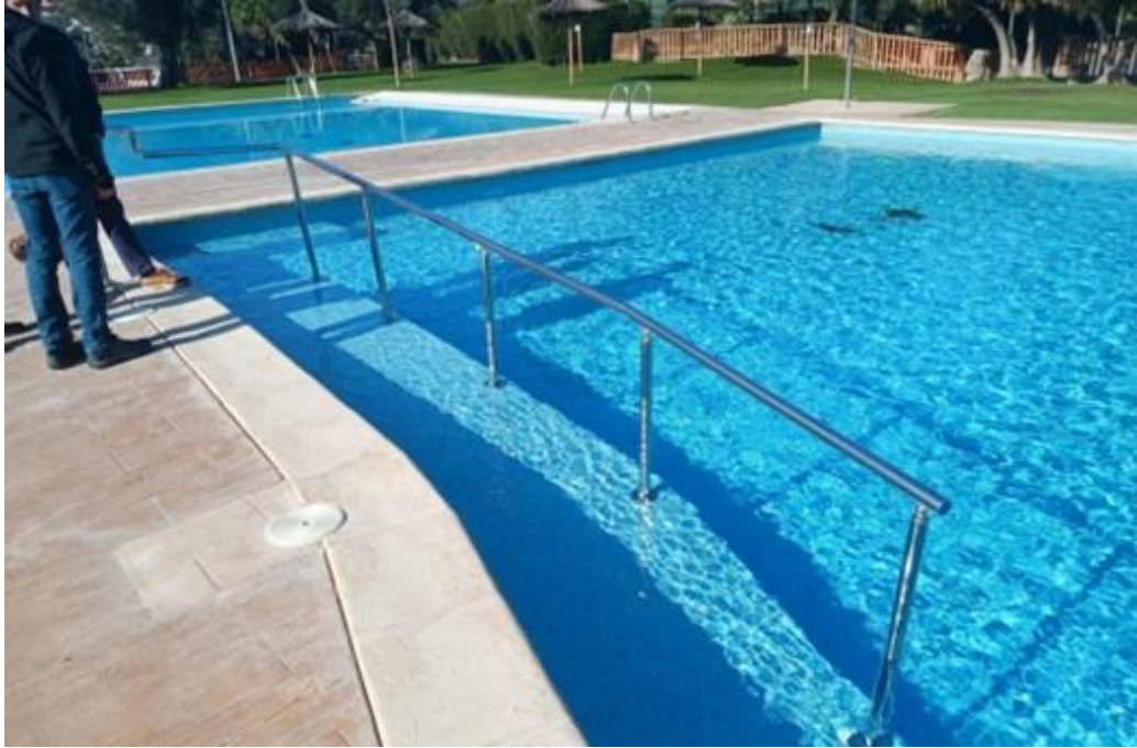
Imatge 5 Rampa d'accessibilitat de piscina N° 3
