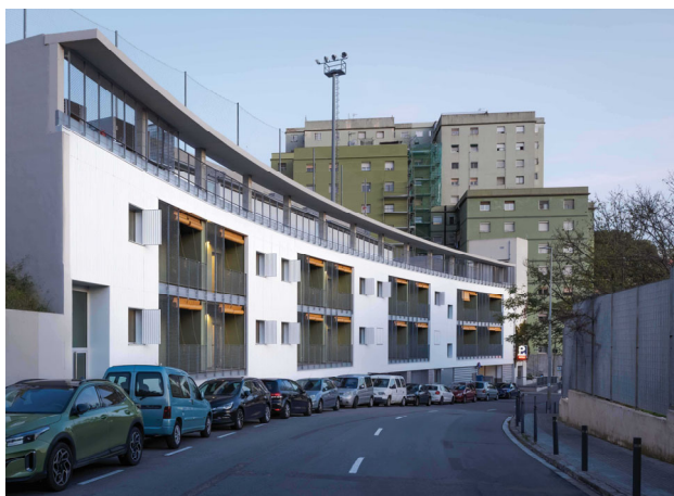
Façana general de l'edifici
