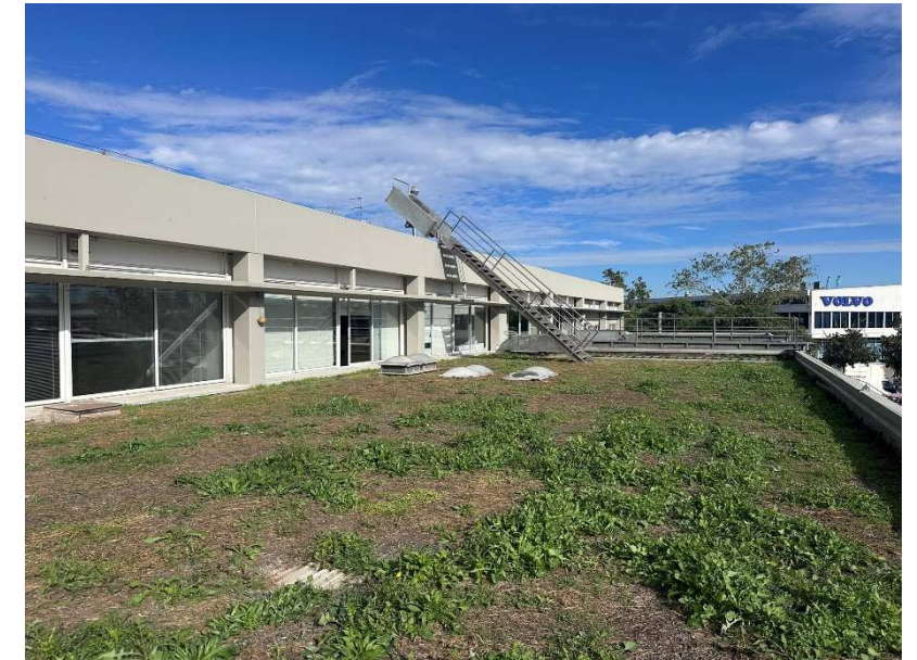
3 Coberta existent amb paquet de terres 40 cm i geotèxtil.
