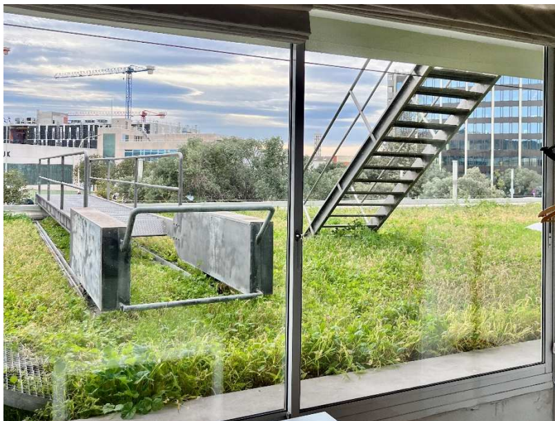
4 Vista des de l'interior d'elements de manteniment integrats a l'actual coberta
