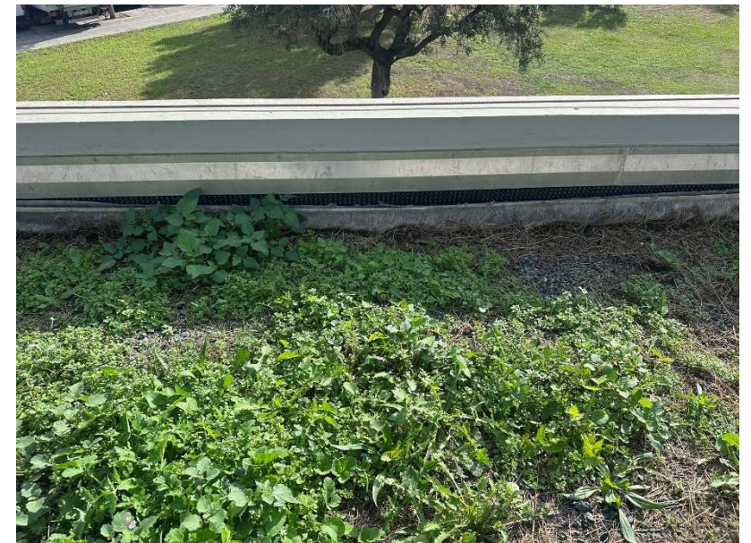
6. Detall muret vora de coberta.
