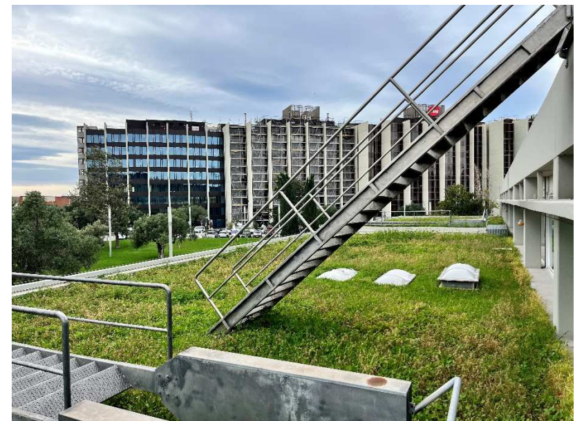
6. Escala metàl·lica de manteniment.
