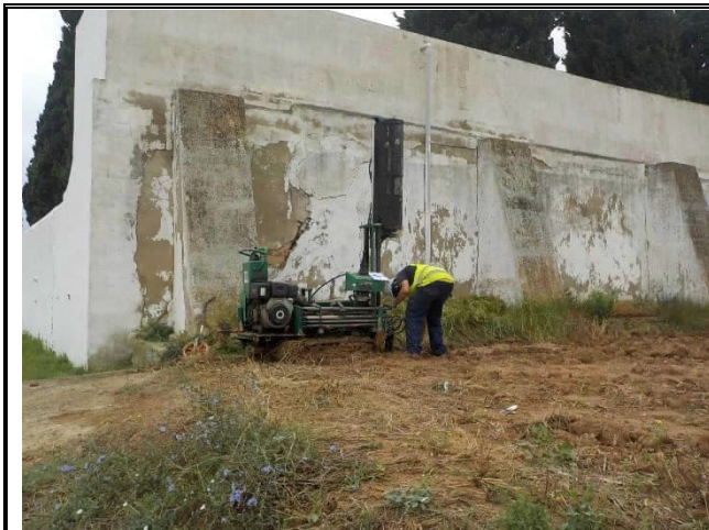
Fotografía nº 7 Ensayo de penetración dinámica continua tipo DPSH, PD-3.
