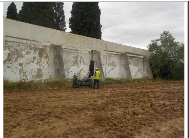
Fotografía nº 8 Emplazamiento del ensayo DPSH PD-4.
