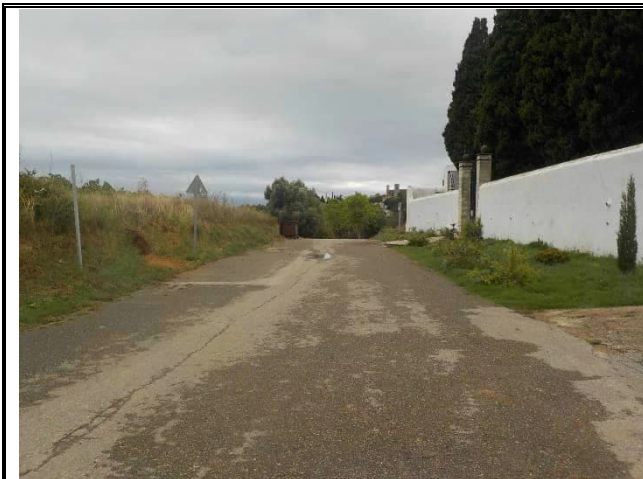
Fotografía nº 1 Vista general del acceso principal al cementerio, fachada este.
