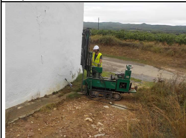
Fotografía nº 5 Ensayo de penetración dinámica continua tipo DPSH, PD-1.
