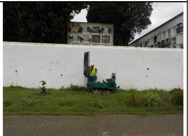
Fotografía nº 6 Ejecución del ensayo de penetración PD-2.
