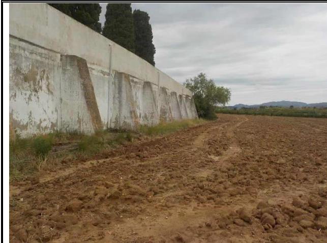
Fotografía nº 3 Vista general de la fachada norte del cementerio.
