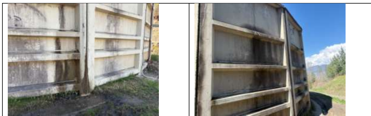
Imatge 4. Estat actual i emplaçament dipòsit Còrrech
