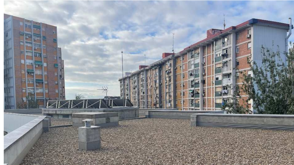
2. Vista de la zona on es mantindran les graves existents.
