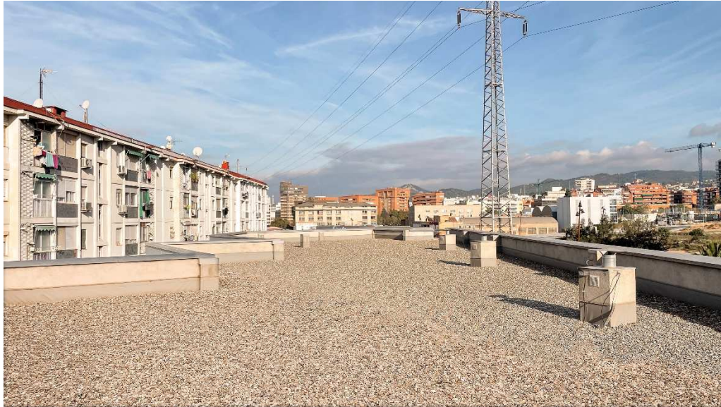
1 Espai de coberta on s'instal·larà el TOPSEC
