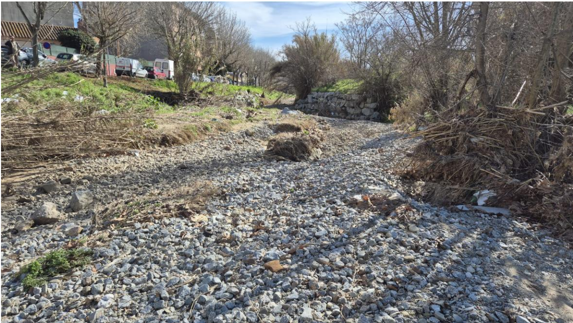
Imatge 8. Tram adequat per la millora l'estructura del sòl dintre dels treballs d'adequació morfològica
