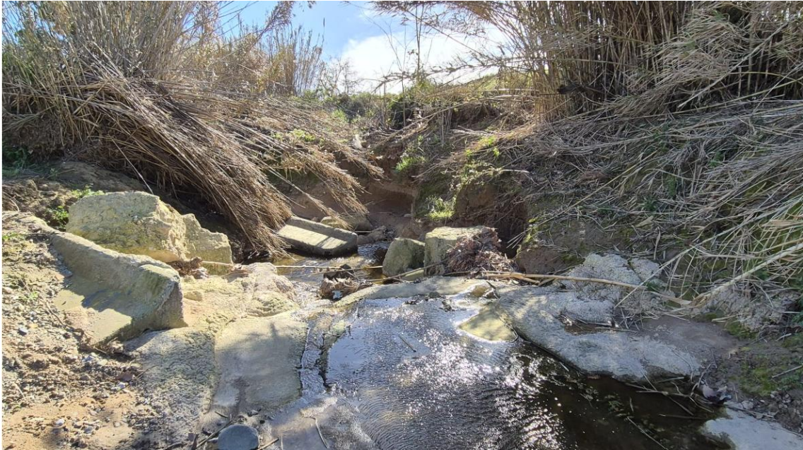
Imatge 3. Tram adequat per alliberament d'obstacles hidràulics
