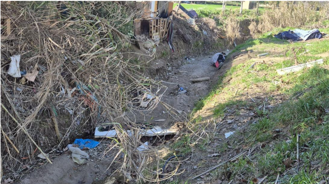
Imatge 6. Tram adequat pel sanejament i ampliació de secció de llera
