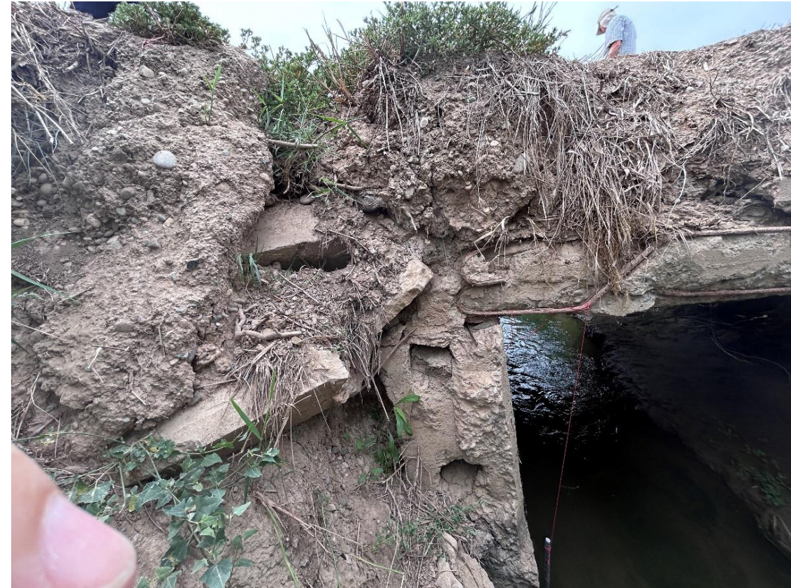
Figura 11. Reblert trasdós estrep dret
