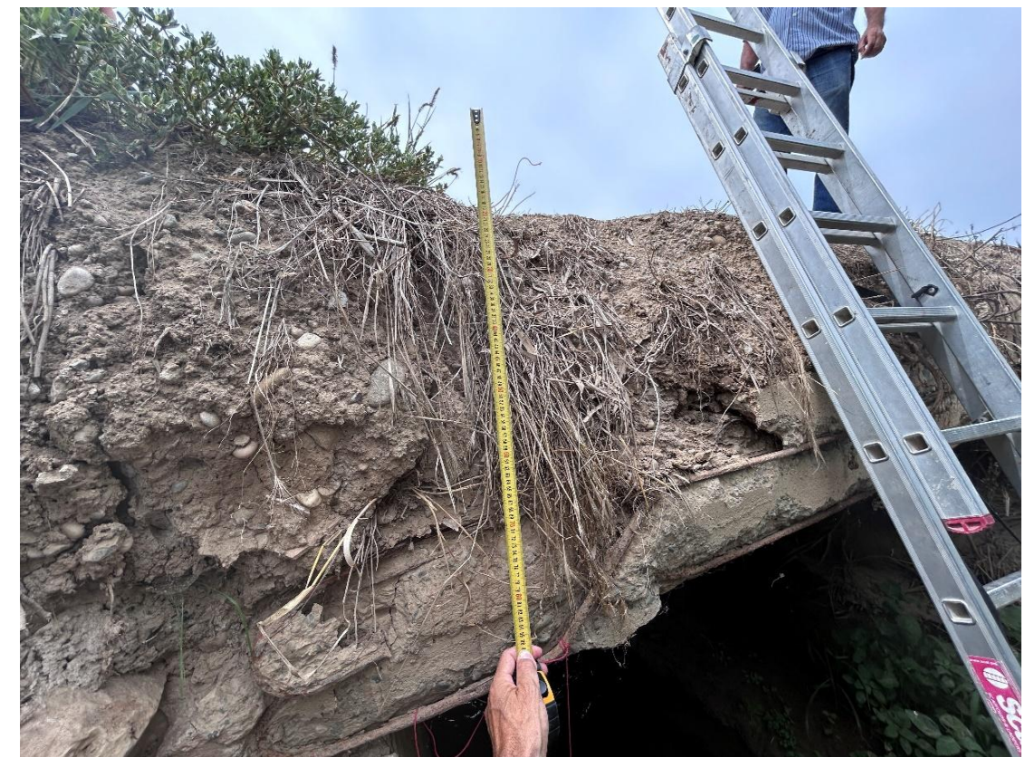
Figura 12. Apilament de terres sobre tauler
