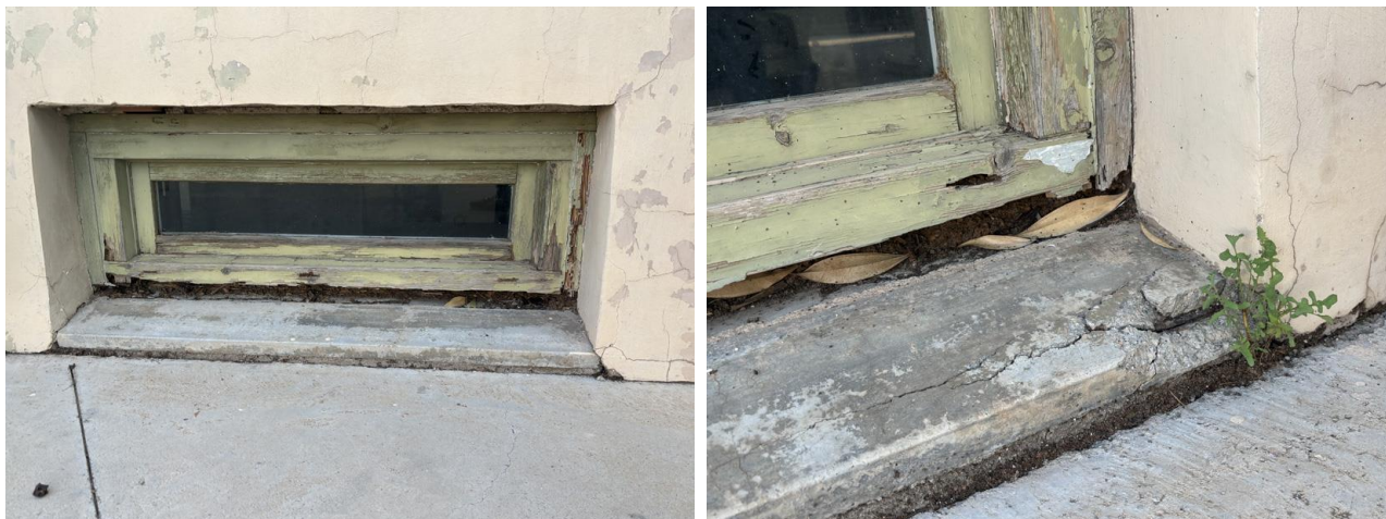
Imatges 250729-05 i 06. Exemples de podriments d'elements de fusta d'escopidors d'una finestra del semisoterrani a la façana principal.
