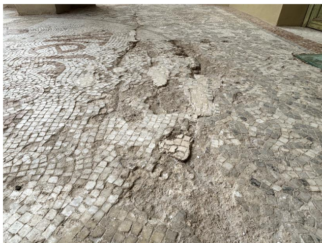
Imatges 250729-90116 i 250912-20. Exemples de l'afectació del deteriorament amb esquerdes, fissuració i desprendiments de tesselles del mosaic.
