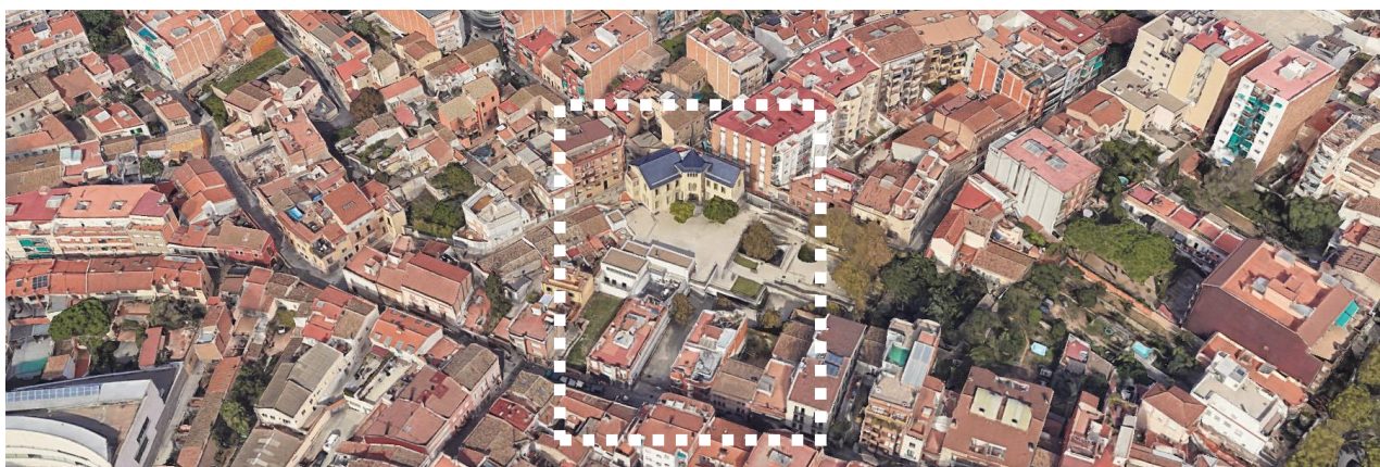
Imatge 1. Fotografia aèria del front principal de l'edifici. Font: Web Google-earth.
