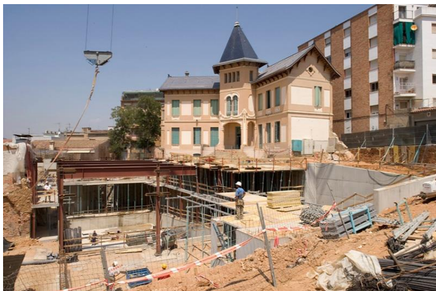
Imatge 04. Construcció de l'auditori semisoterrat arran de l'edifici històric, entre 2006 i 2007. Autor: Lluís Casals. Font: Fons Fotogràfic Lluís Casals / Arxiu Històric COAC.
