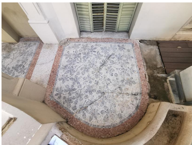
Imatges 250729-90116 i 250912-20. Exemples de l'afectació del deteriorament amb esquerdes, fissuració i desprendiments de tesselles del mosaic.
