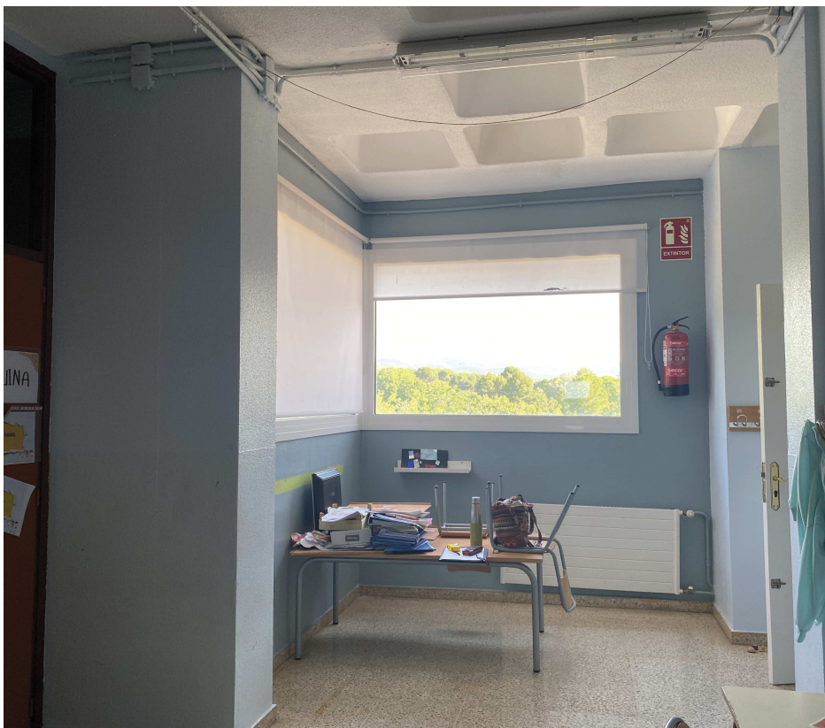
D.F.4 Passadís planta primera per on s'accedirà a l'ascensor.
