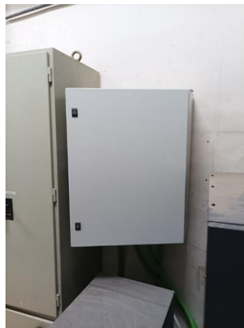
Alguns del mòduls elèctrics a retirar ja que les seves proteccions restaran al nou quadre proposat i instal·lacions actuals de la sala elèctrica a modificar
