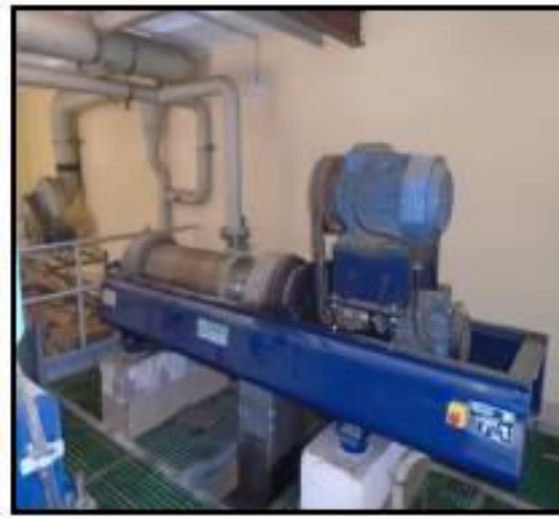
Figura 2. Centrífuga núm. 1 marca Guinard D3 LC 30 C HP a l'EDAR de Llança
