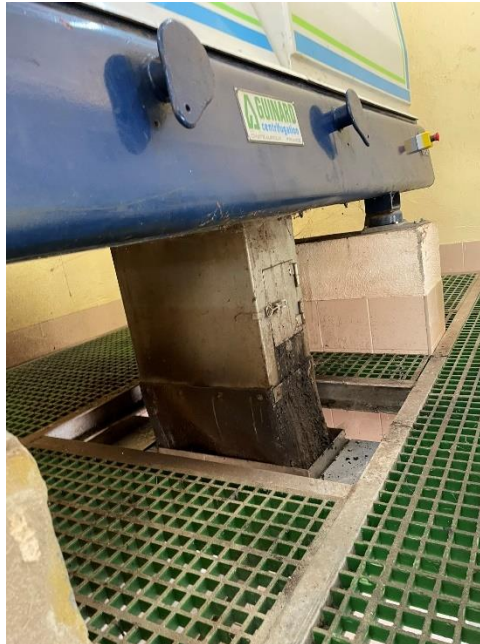
Figura 7. Tremuja de fang deshidratat existent a connectar a nova centrífuga
