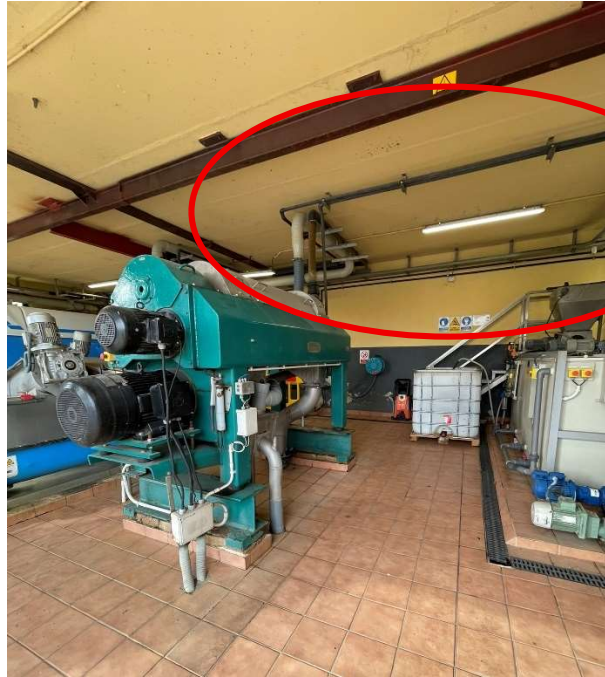
Figura 17. Canonades del sostre que cal desplaçar per instal·lar la biga
