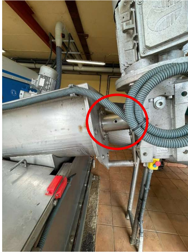
Figura 8. Connexió reductor-cargol transportador
