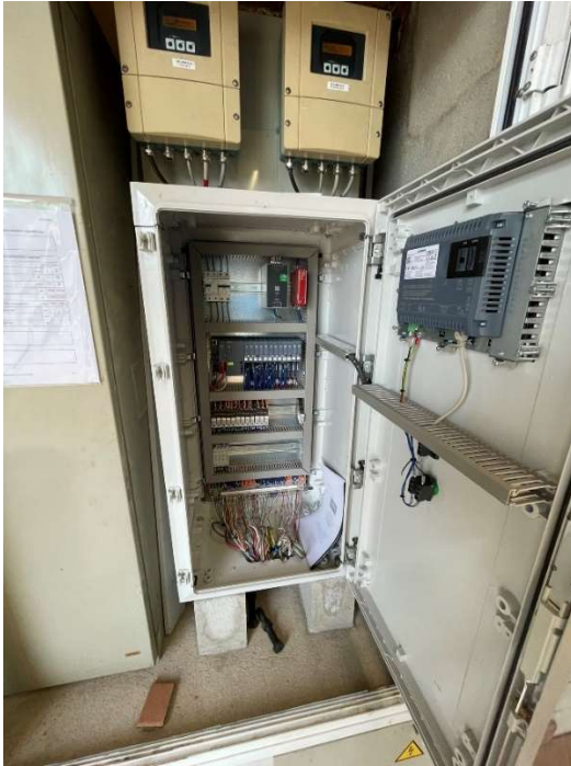
Figura 22. Adequació de l'armari elèctric a realitzar
