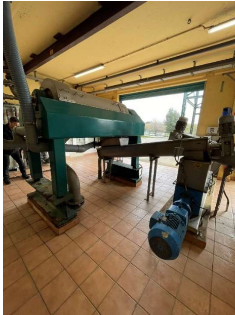
Figura 9. Antiga centrífuga a desmuntar
