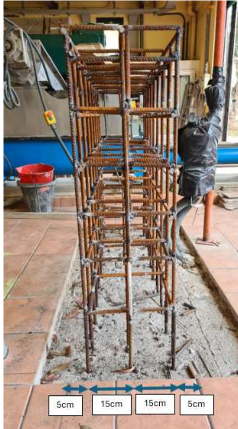
Figura 11. Detall de l'armadura a col·locar
