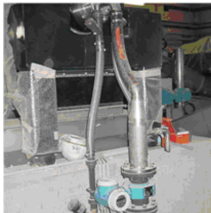
Figura 14. Recogida de muestras para los lodos de alimentación.
