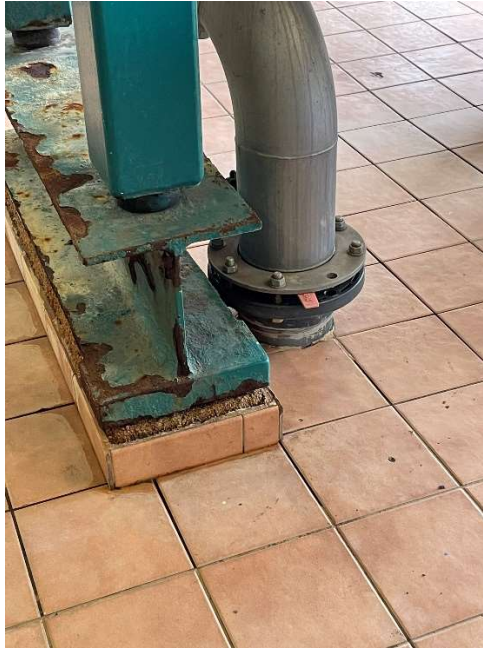
Figura 10. Detall de la bancada existent
