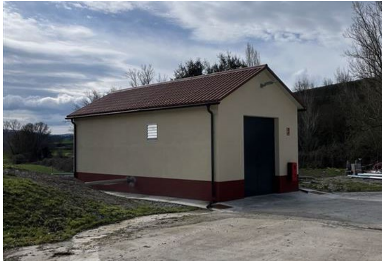
Figura 3. Caseta auxiliar on s'ubica el subquadre de bufants
