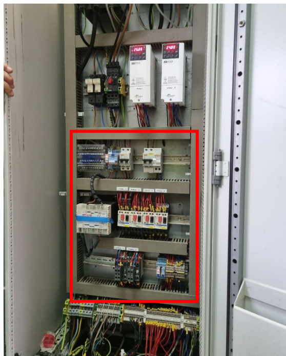
Figura 10. Aparamenta a desconnectar i retirar del subquadre de bombes de fang
