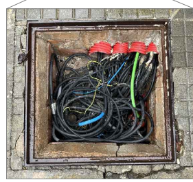
Vista de l'interior de les arquetes existents
