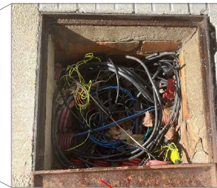
Vista de l'interior de les arquetes existents
