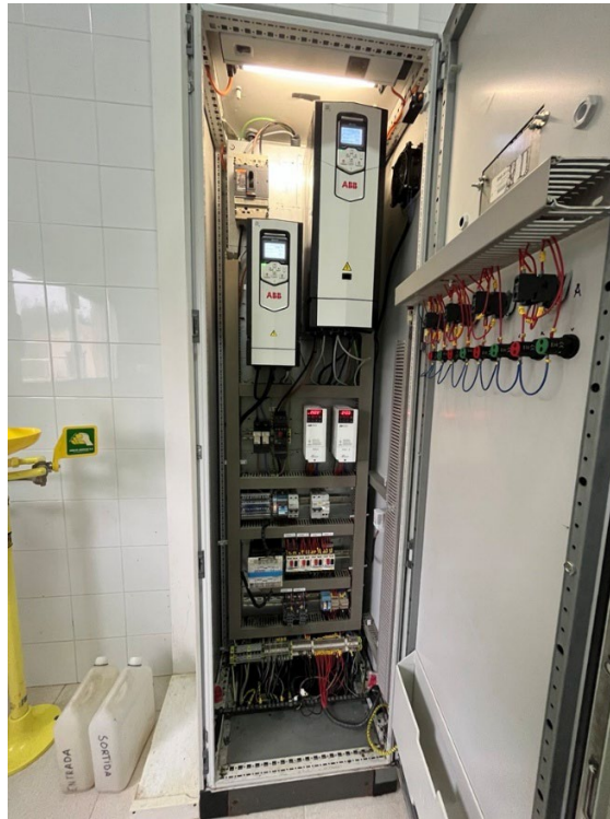
Figura 9. Vista de l'interior del subquadre de bombes de fang
