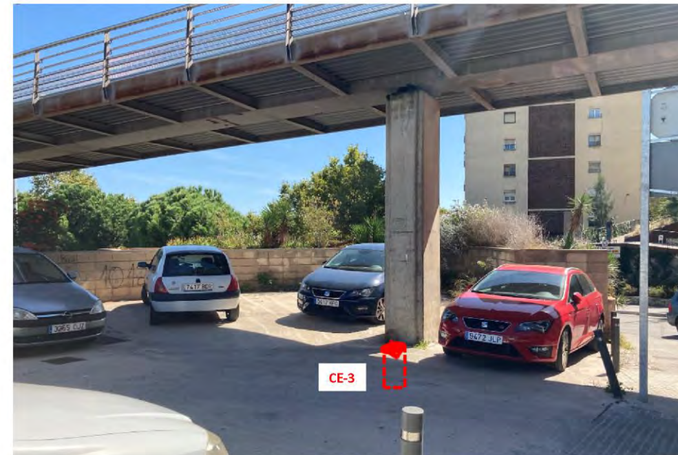
CE-3. Cala per confirmar la fondària de la sabata del pilar de la passera.
