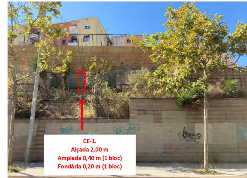
CE-1. Cala frontal fins cara inferior de sabata del mur de formigó armat.
