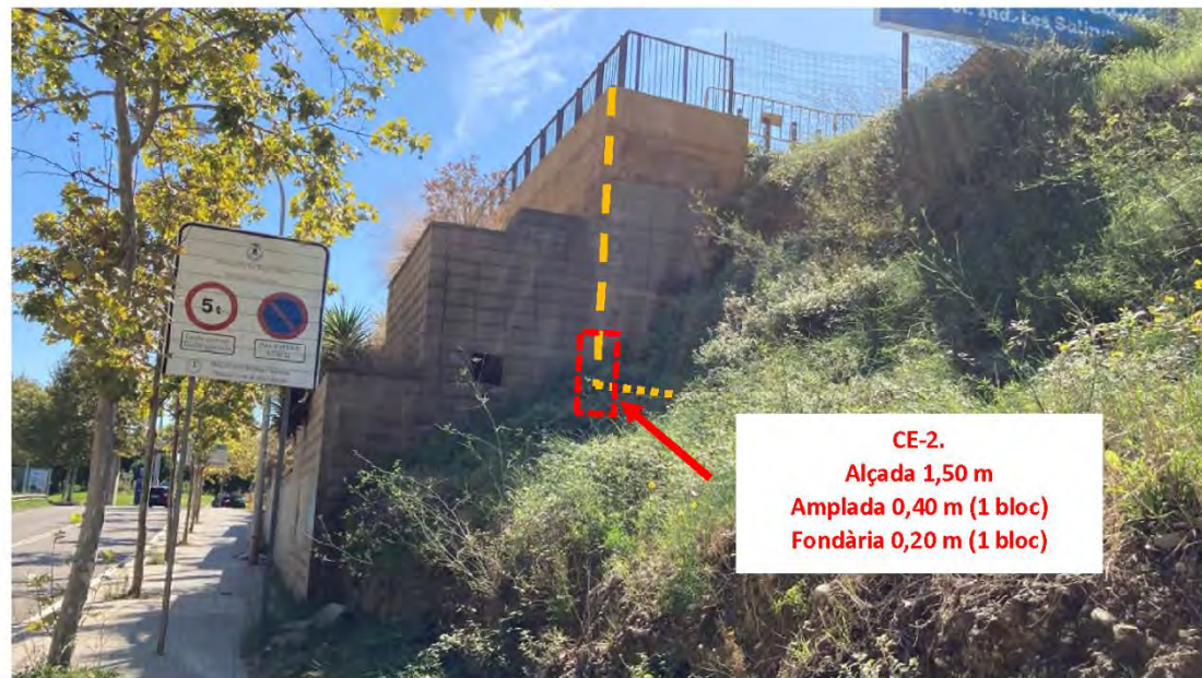
CE-2. Cala lateral per descobrir mur i sabata de formigó armat.
