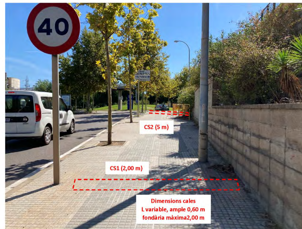
Detall cales en vorera per detecció de serveis. Enganxades al mur existent i de 2 m de llargada.
