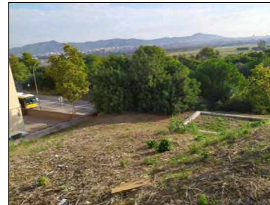
Vista del talús.
