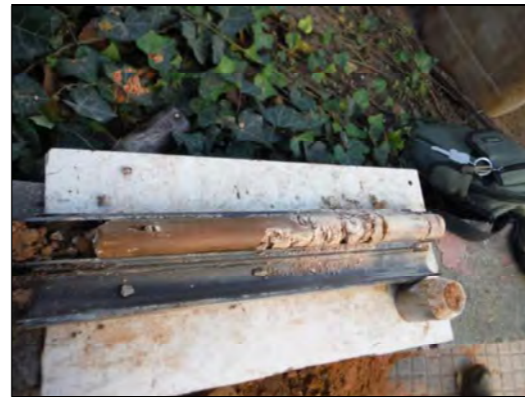
Foto 4: Sondeig S-1, SPT a 4,8 metres.
