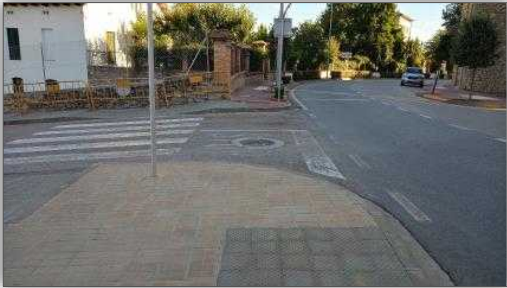
Foto. 3 – Creuament C. de les Entitats amb Carretera De Prats.
