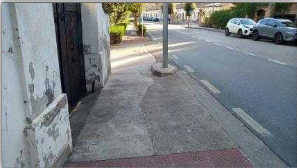
Foto. 4 – Creuament Camí del Pont Vell amb Carretera De Prats.
