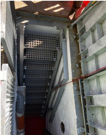
Fig. 2. Escales d'accés d'acer galvanitzat o PRCV.
