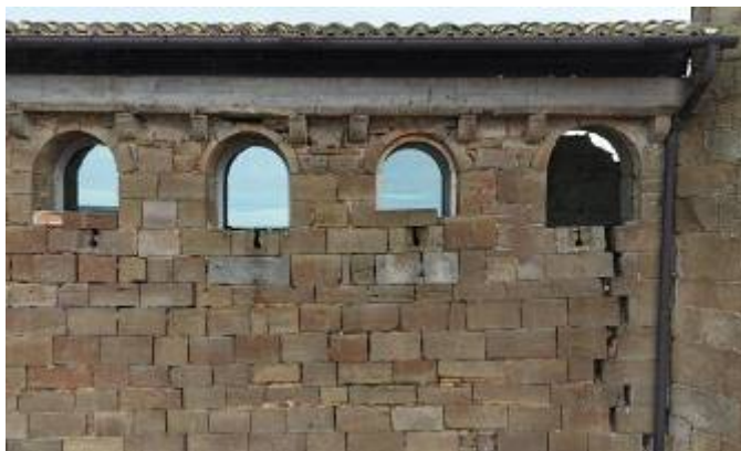
Part de la galeria superior on trobem dues obertures que han perdut el seu ampit. Cal recordar que les dues situades a l'extrem dret van ser destapiades a finals del segle passat.
