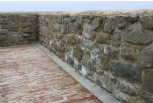
Detall del mur del costat occidental de la terrassa amb l'evident presència de sals en superfície i vista del forjat de ciment que amaga la recollida d'aigua pluvial.
