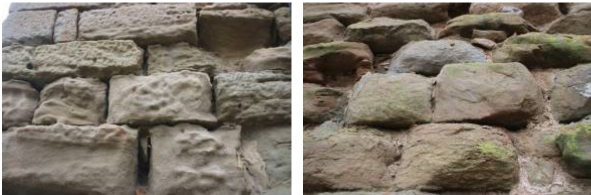
La disgregació del suport petri suposa important retrocés i pèrdua de material
