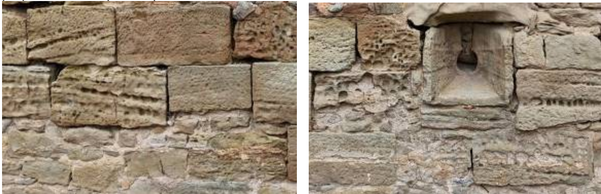
Formació d'alvèols en carreus del tram central de la façana oest del castell
