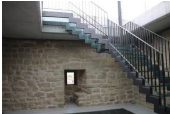
Detall del mur del costat occidental de la terrassa amb l'evident presència de sals en superfície i vista del forjat de ciment que amaga la recollida d'aigua pluvial.
