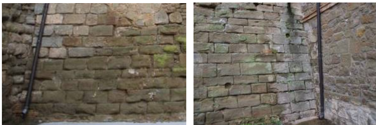
Detall dels tres baixants que aporten aigua als peus de la façana oest del castell.
