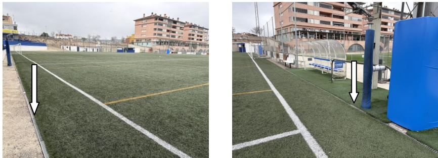
Situació de les reixes de canalització de les aigües superficials
