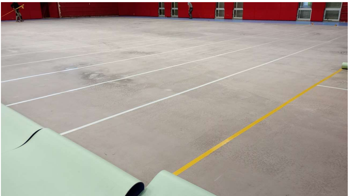
Solera formigó pista existent (abans de la instal·lació Paviment vinílic actual pista)
