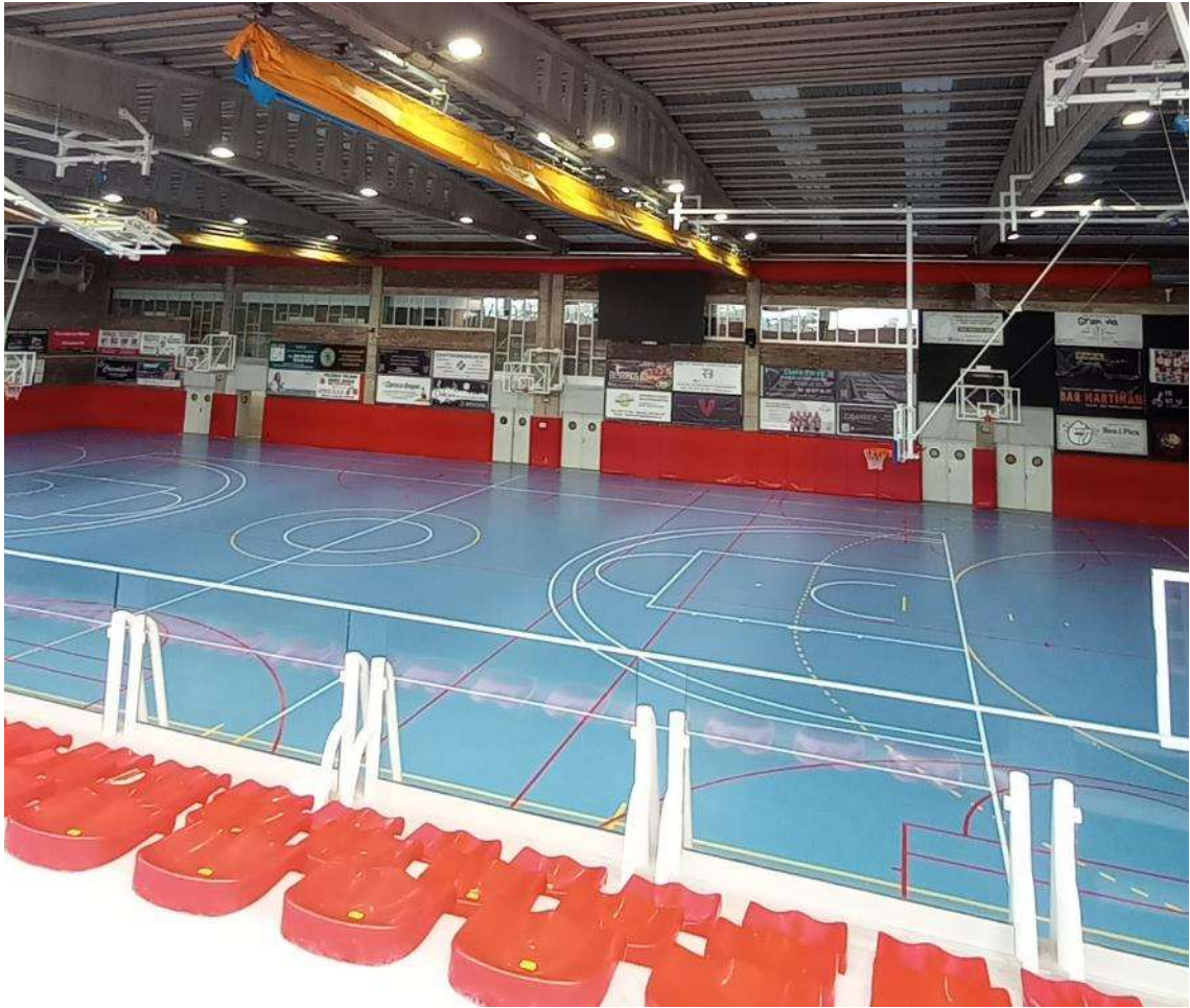
Paviment vinílic actual pista
