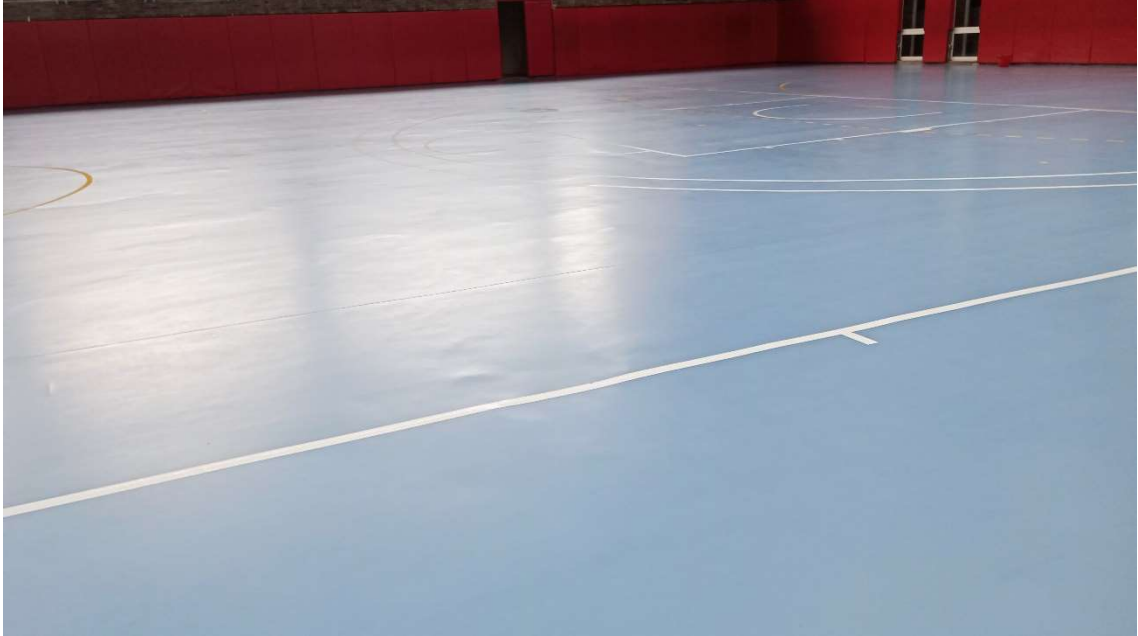
Paviment vinílic actual pista
