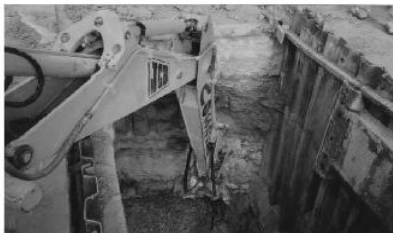
DEMOLICIÓN MECÁNICA EN ZANJA
