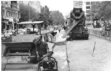
VERTIDO DE HORMIGÓN DE FIRME
