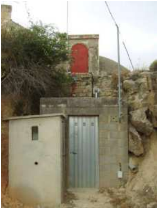
Figura 2. Vista exterior del dipòsit de la Mancomunitat al Vilosell
