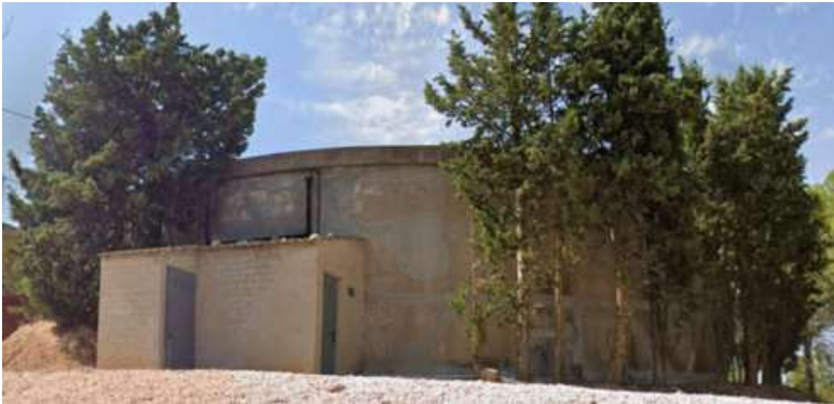
Figura 3. Vista exterior del dipòsit nou del Vilosell
