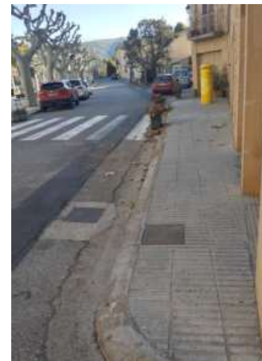
Figura 10. Inici Plaça Sant Sebastià (vista oest, zona panot)
