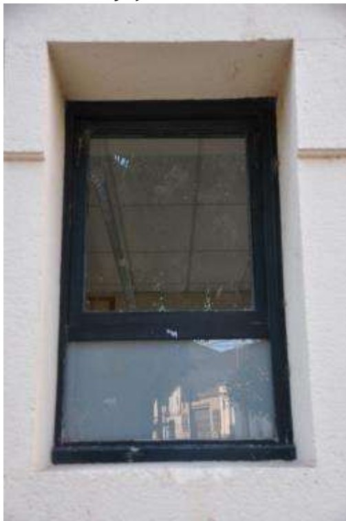
F08 Situació façana nord
