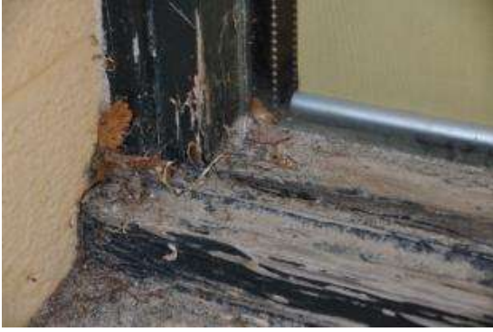
F14 Situació façana est
