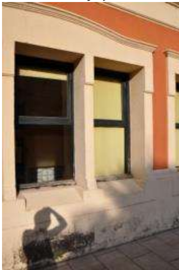
F13 Situació façana est
