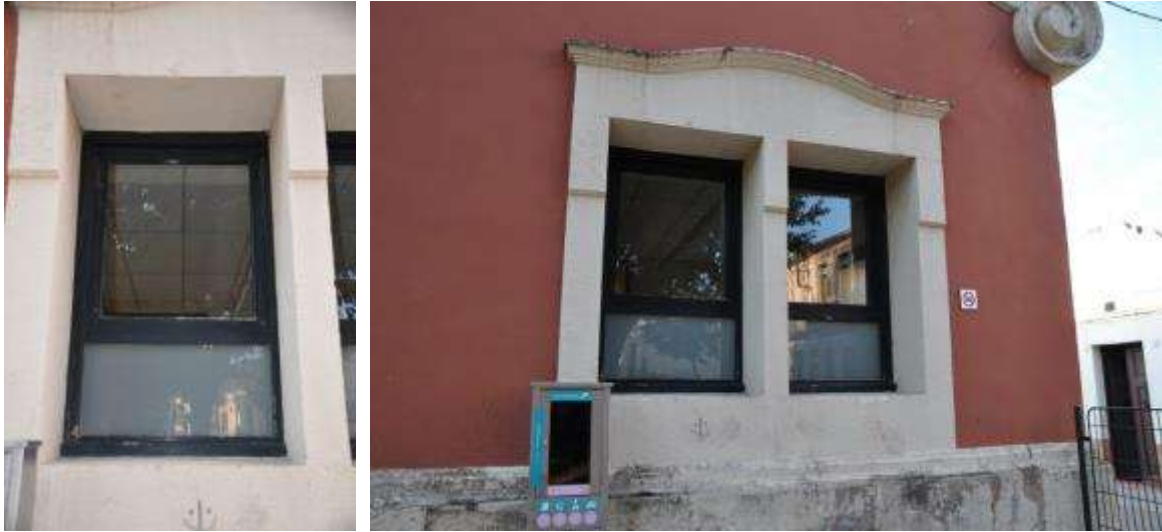
F07 Situació façana nord
