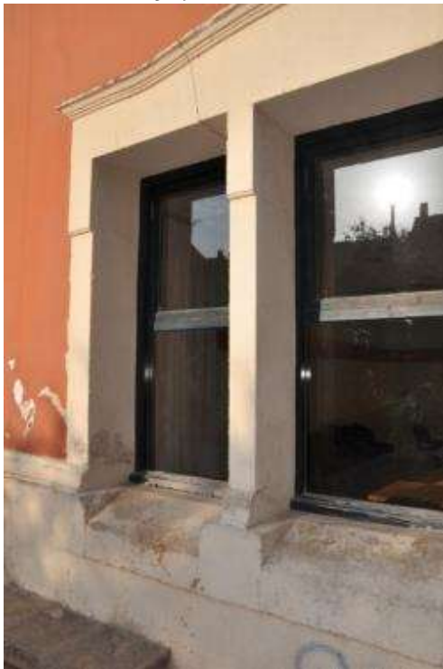
F18 Situació façana est
