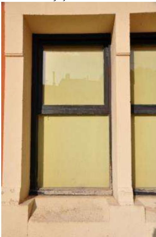
F23 Situació façana est
