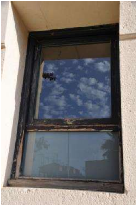
F29 Situació façana nord
