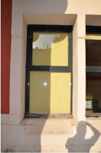
F15 Situació façana est
