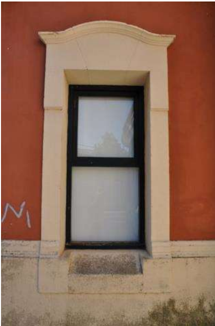
F16 Situació façana est
