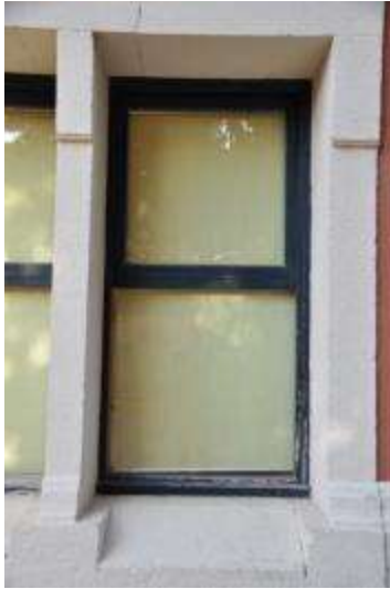
F11 Situació façana est
