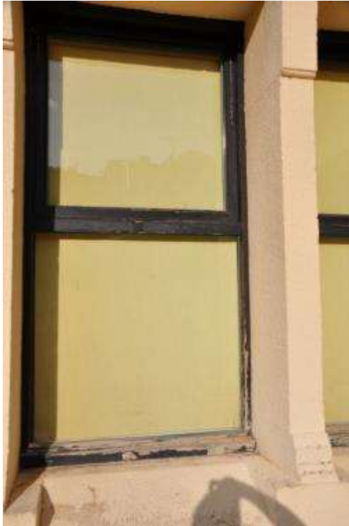
F22 Situació façana est
