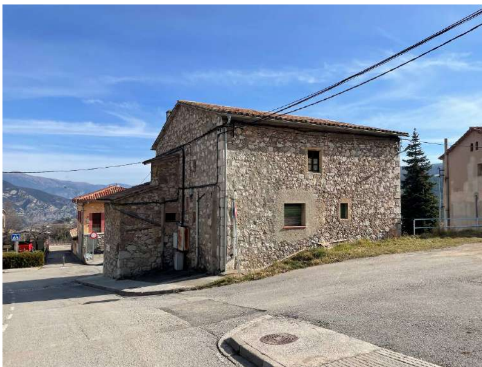
Fotografia 3 – Façana de ponent o SO des de la carretera de la Mina. A la dreta de la imatge es veu l'accés a la plaça dels Països Catalans. A l'esquerra de l'immoble es veu el cos annex de construcció posterior amb la caixa d'escala a P1 i l'accés al CAP.
