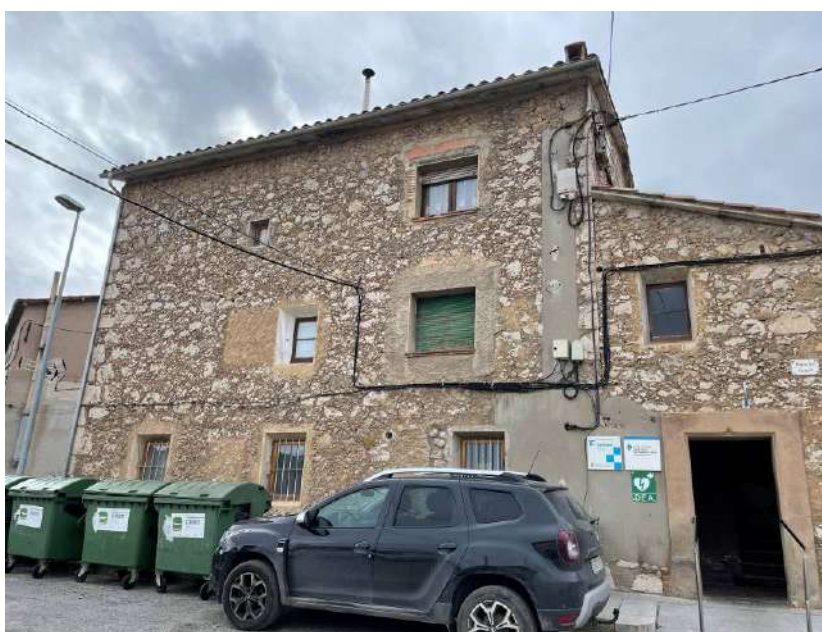
Vista de la façana del costat nord-est amb el cos original i l'annex posterior amb les escales d'accés a P1 i P2.
