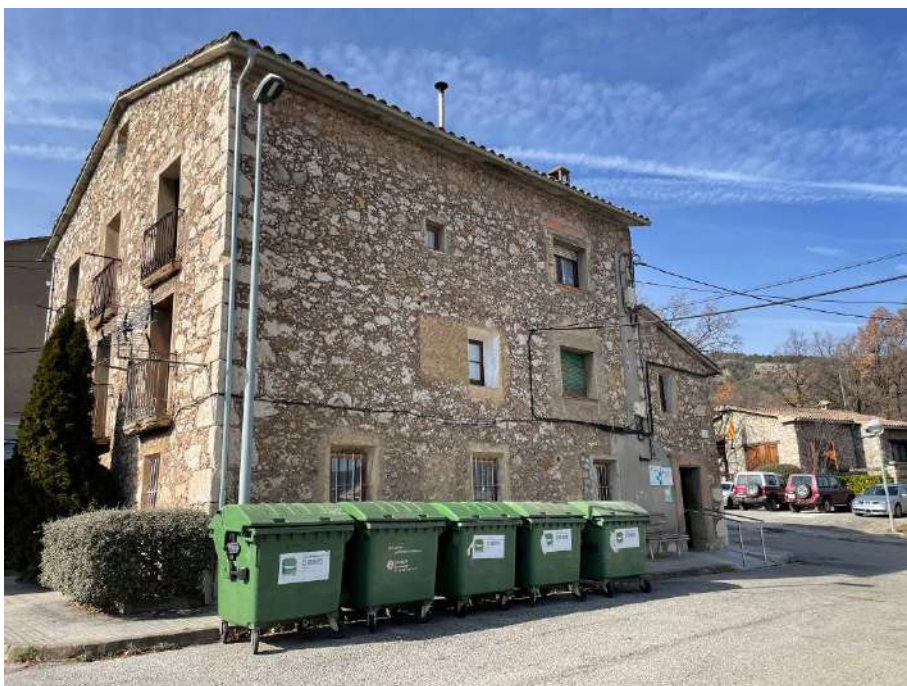
Fotografia 2 – Façana de llevant o SE vista des de la plaça de l'Ajuntament. A la dreta de la imatge es pot veure l'accés al CAP i als habitatges de plantes superiors en un annex de construcció postrior a la principal.
