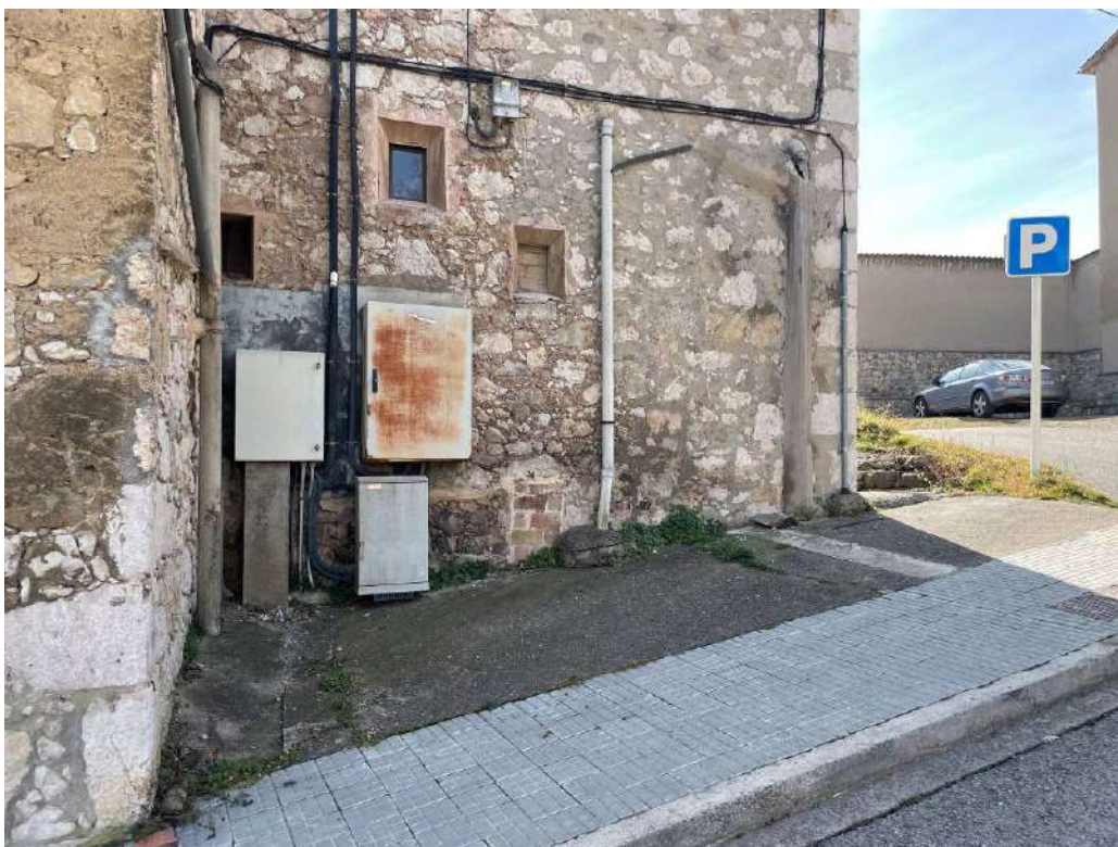
Fotografia 7 – Placeta posterior de la façana nord, a la carretera de la Mina, a on s’executarà un recrescut fins a cota de P1 per accedir als habitatges directament sense el tram d’escales interior.
