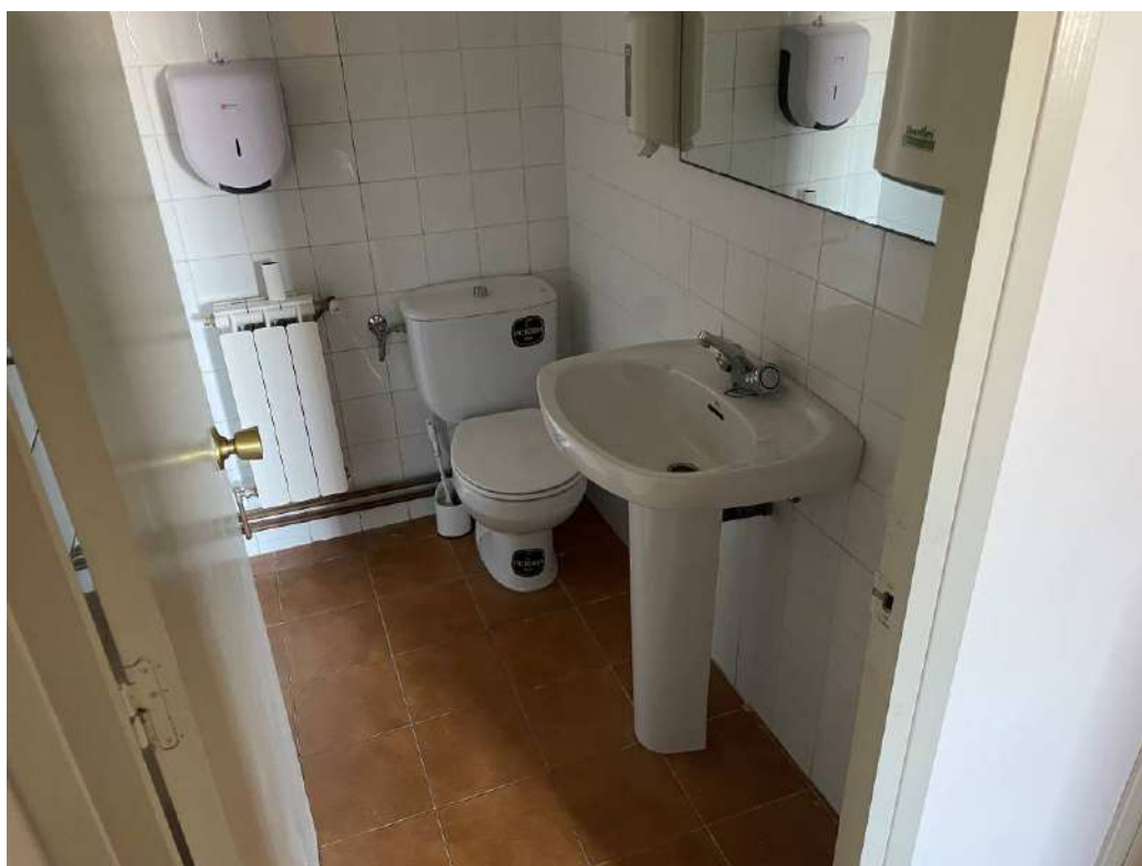
Fotografia 20 – Lavabo no accessible 1.
