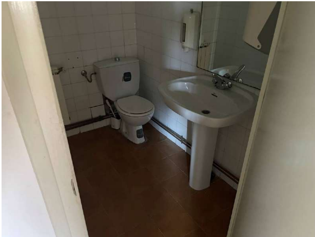
Fotografia 21 – Lavabo no accessible 2.
