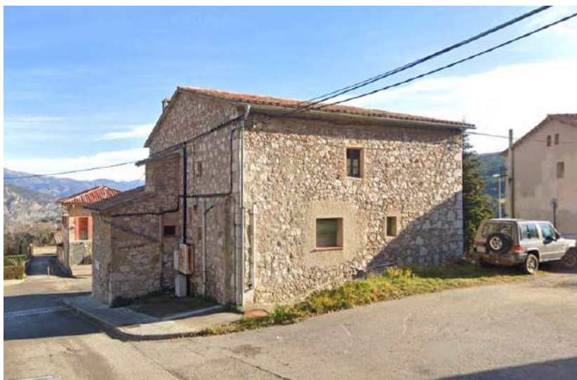
Vista de les façanes sud-oest al costat esquerre de la imatge i nord-oest a l'esquerra. Aquesta darrera façana (posterior) força mal tractada pels serveis que hi pengen és la que s'acaba fent més visible des de la carretera de la Mina.
