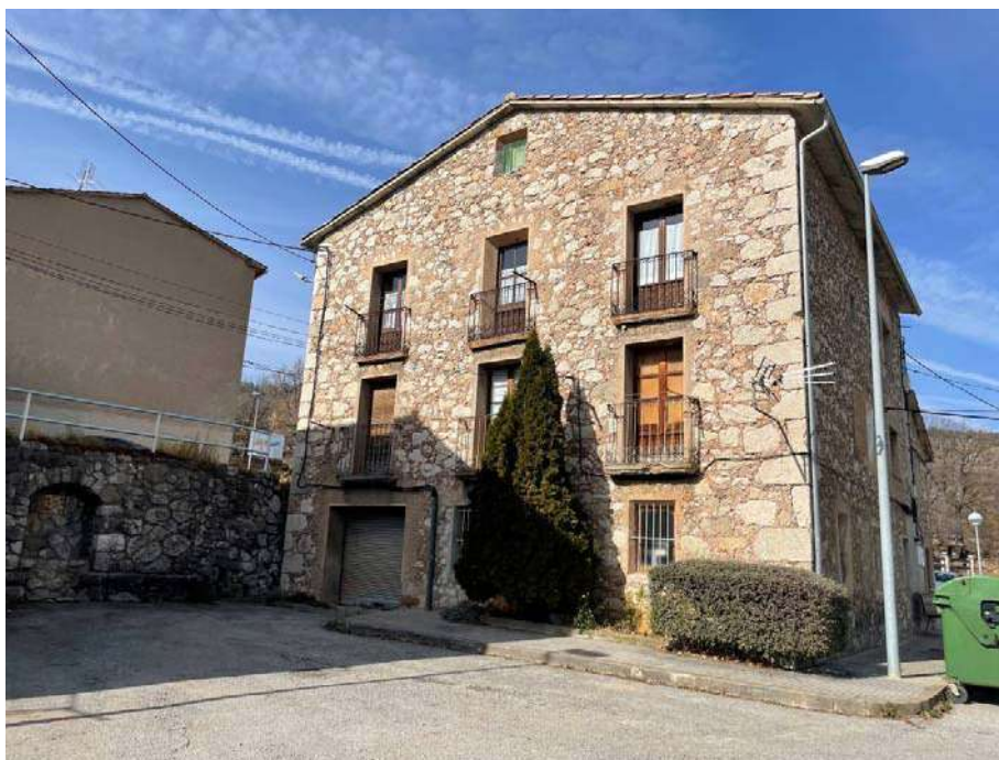
Fotografia 1 – Façana principal des de la plaça de l'Ajuntament. L'espai frontal de la façana és la plaça del Roser amb la font a l'esquerra de la imatge. Aquest espai és objecte d'una altra actuació per a recuperar l'entorn de l'immoble i acompanyar el canvi d'accés al centre mèdic per la façana principal de l'immoble. L'immoble està construït en planta quadrada dividida en tres cruïxies allargades (ponent a l'esquerra, central i llevant a la dreta).
