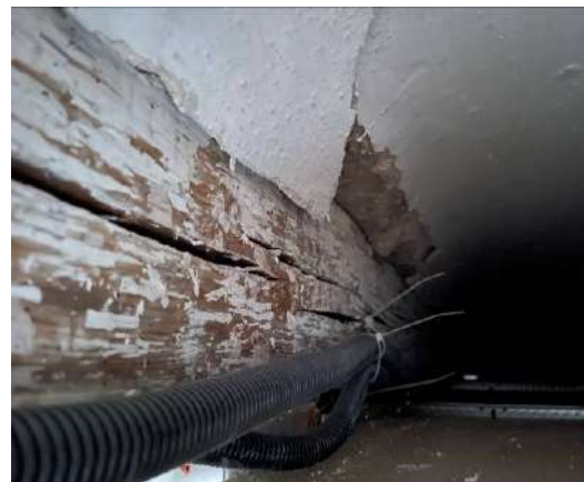
Fotografia de biga de sostre de PB cruixia llevant
