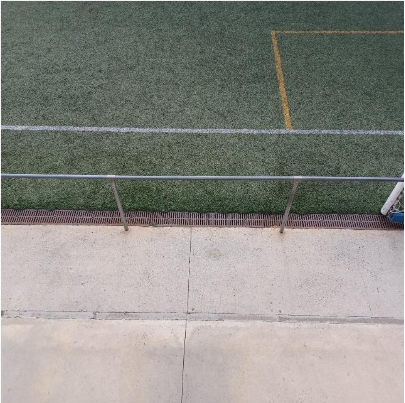
Detall trobada gespa terreny de joc amb vorera perimetral.
