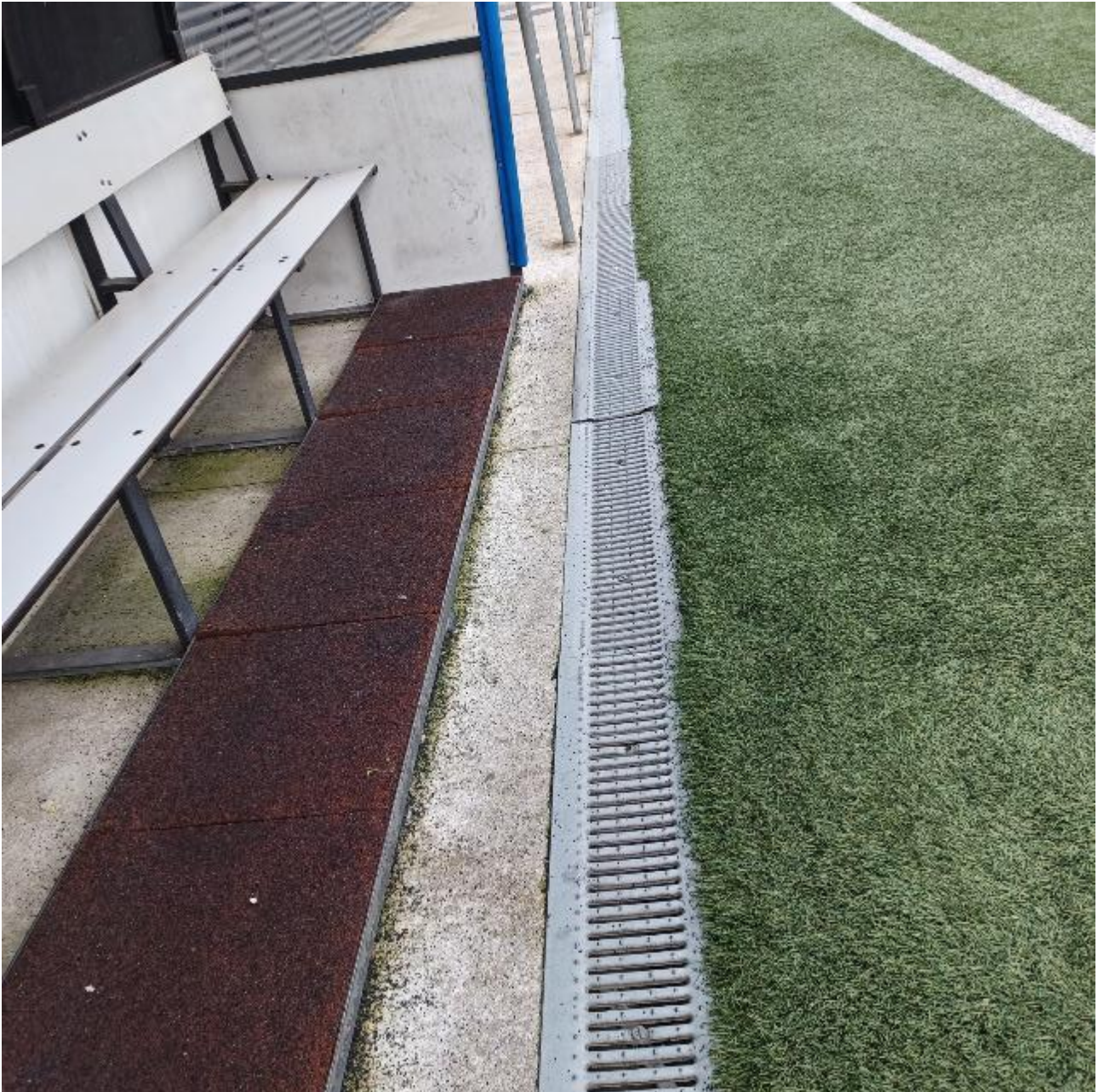
Detall trobada gespa terreny de joc amb reixa captació aigües pluvials i reg
