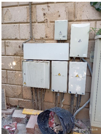
Imatge 1 i 2 Caixa General de Proteccions
