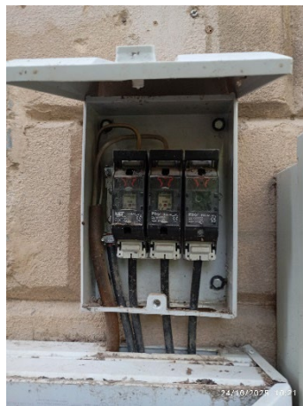
Imatge 1 i 2 Caixa General de Proteccions
