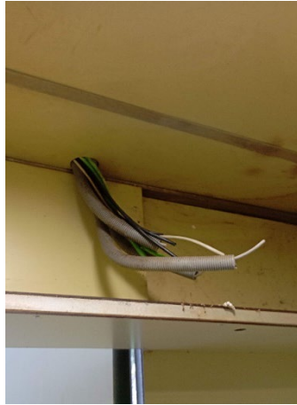
Imatge 21 i 22 instal·lacions en mal estat Zona Office
