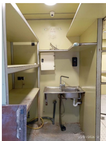
Imatge 18 General Zona Office
