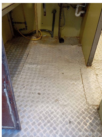
Imatge 19 Paviment Zona Office
