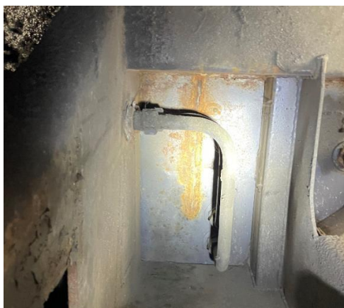
Figura 11: zona de corrosió a les canonades i sota la porta.
