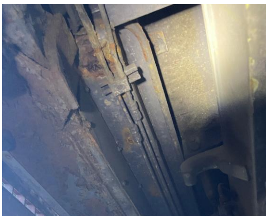
Figura 11: zona de corrosió a les canonades i sota la porta.
