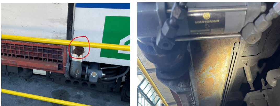
Figura 7: zones corroïdes; al costat i sota la porta
