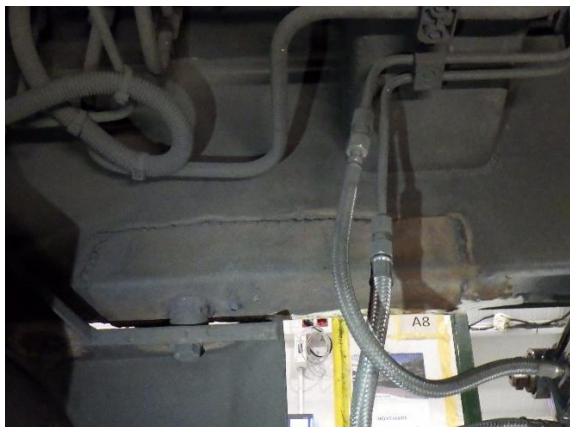
Pos. 15: reparació de soldadura de la biga longitudinal a la zona del suport de muntatge per a la escombradora de via.
