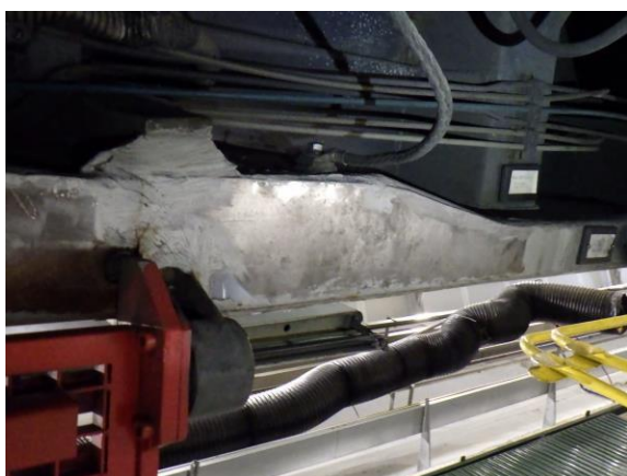
Pos. 04: reparació a la biga longitudinal. L'estructura es tanca amb una placa d'unió.
