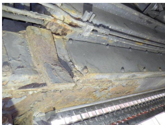
Pos. 07: corrosió forta prop de la porta d'entrada. La parada del bogi mostra deformació. La distància fins la parada del costat oposat pot ser diferent de la tolerància (vegeu la il·lustració 802.016.210).
