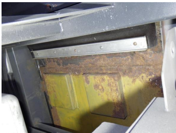
Pos. 12: corrosió en un element de terra instal·lat posteriorment. L'acabat protector contra l'òxid sembla no ser suficient.
