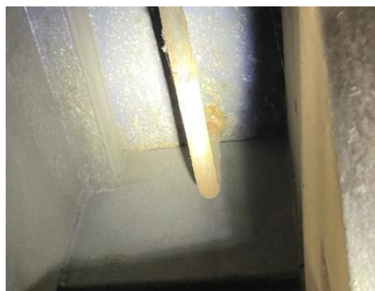
Figura 10: zona de corrosió a la canonada de drenatge i a les canonades
