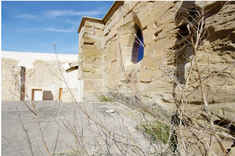
Vista de la cubierta de la capella sud:
