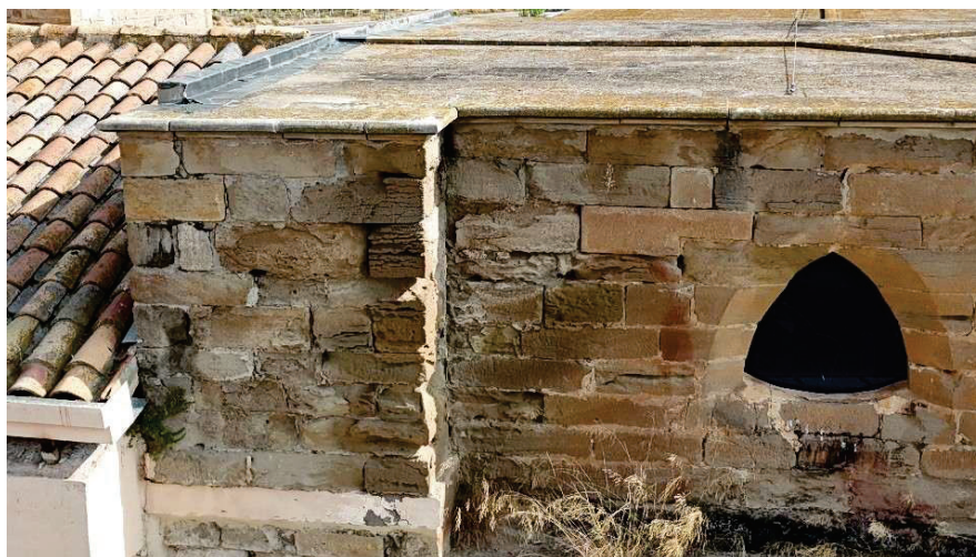
La fàbrica de carreus del parament superior de la façana sud presenta degradació d'alguns carreus i rentat de juntes
