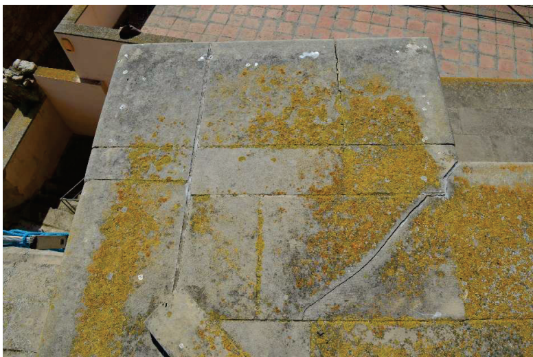
La fàbrica de carreus del parament superior de la façana sud presenta degradació d'alguns carreus i rentat de juntes
