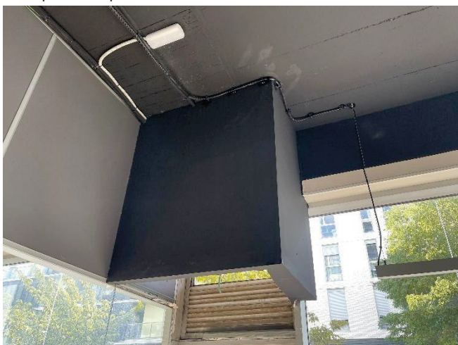
3.Sala: Parament vertical allotjament màquina aire condicionat.
