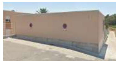
Central de producció de fred i calor
