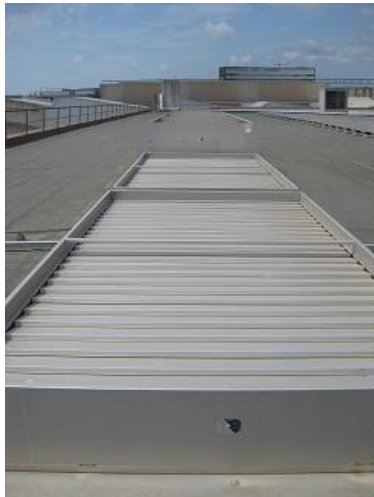
Foto 1. Exutorios no transitables distribuidos por toda la cubierta sin señalizar y sin proteger
