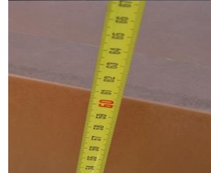
Foto 2. Muros de protección de cubreras a baja altura
