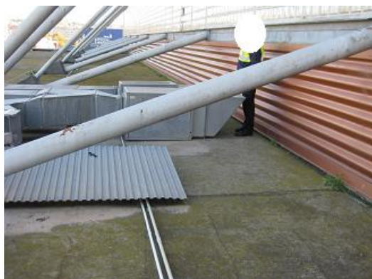
Foto 1. Elementos estructurales y de maquinaria a diferentes alturas en zonas de paso.
