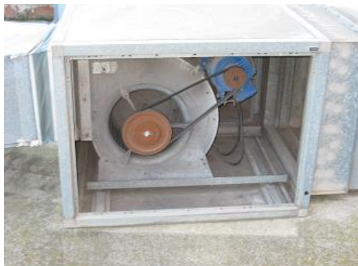
Foto 1. Engranajes de motor desprotegido
