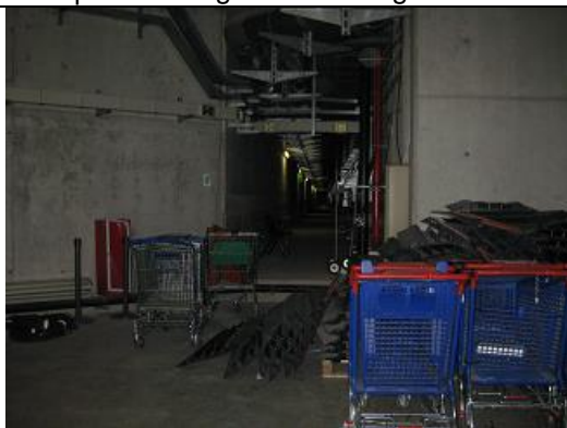
Foto 3. Restos de materiales obstaculizando acceso a galería transversal 3.10.
