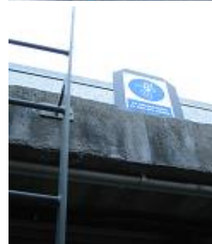
Foto 2. Desembarco desde escala a cubierta con obstáculos que dificultan y alejan el acceso a la línea de vida.
