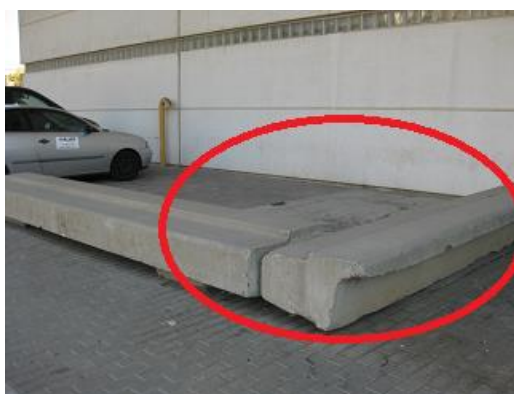
Foto 2. Vista exterior de trampilla en rambla 3-2.
