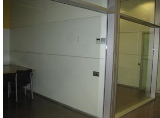
Foto 4. Tabiques acristalados como sistema de división de salas sin señalización o barrera que impida contacto con ello.
