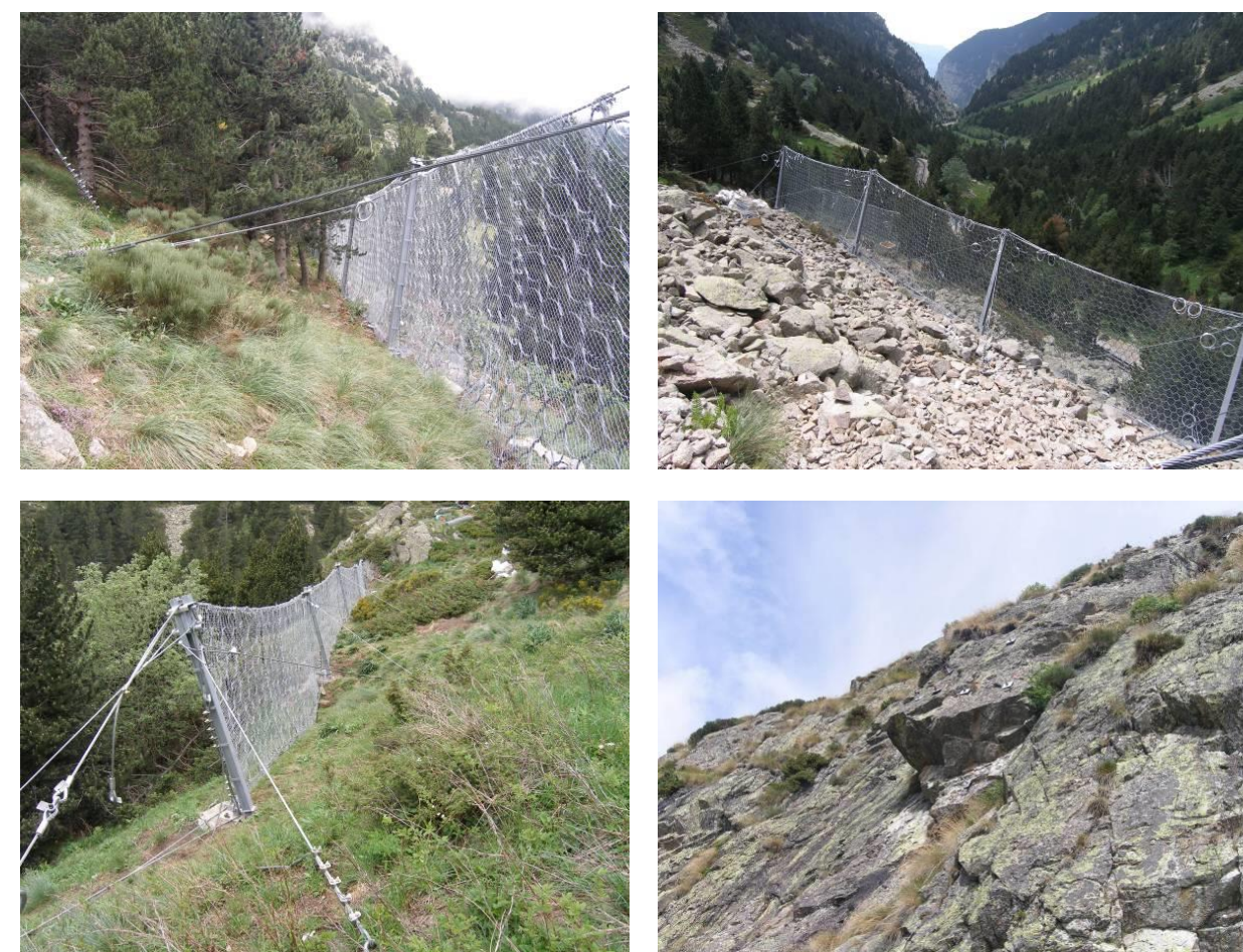
Fig. 1. Fotografia de les actuacions d'instal·lació de barreres dinàmiques i estabilització de blocs al vessant, realitzades l'any 2007.
