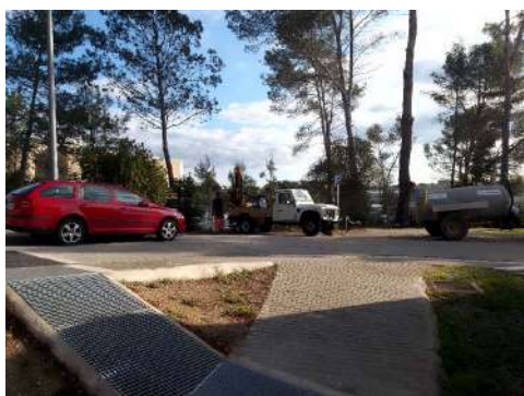
Zona d'intervenció i execució de reconeixements a la capçalera del talús.
