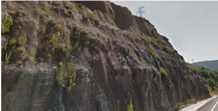
Exemple de talús excavat en terrenys molt susceptibles a l'erosió (margues amb nivells alternants de sorrenques) protegit amb geotèxtil, fixat amb malla d'acer, cable i perns.
