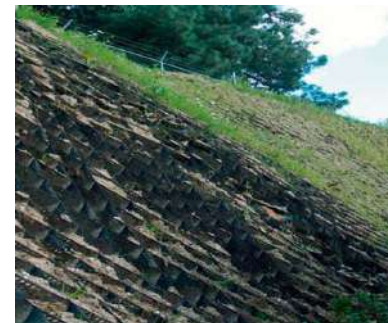
Talús protegit amb geocel·les i revegetació.
