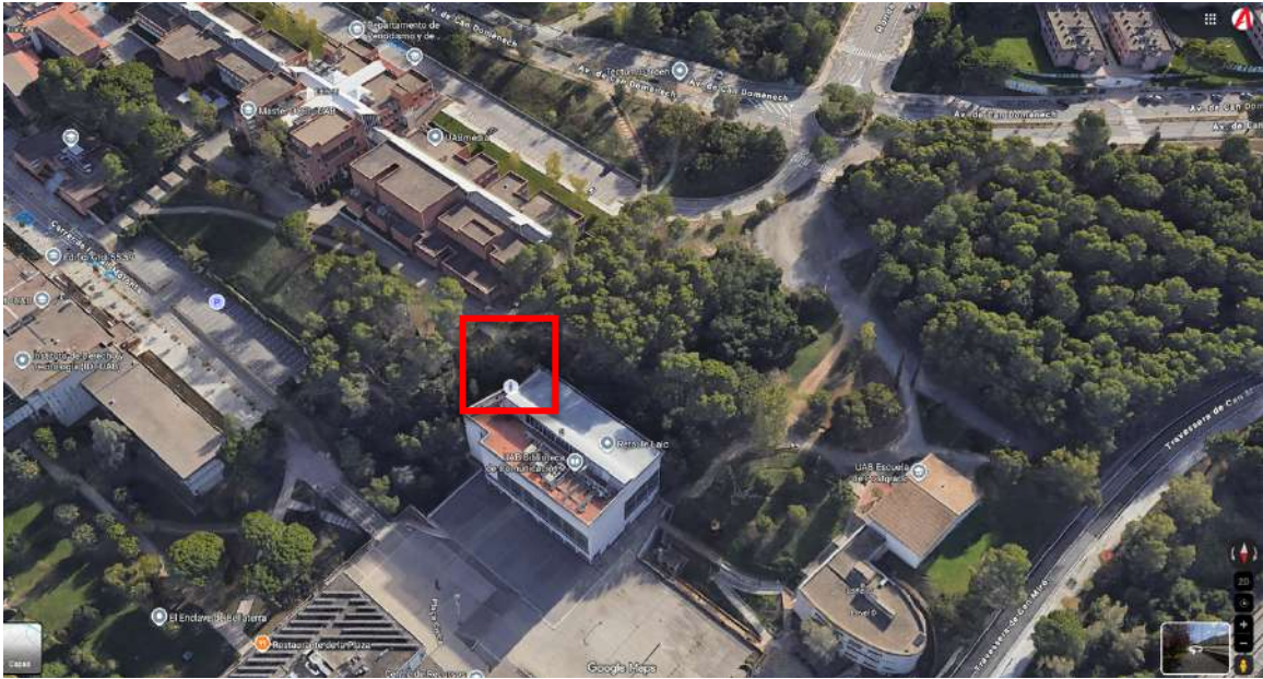
→ IMATGE 5. Vista aèria i localització del talús en el complex UAB. Font: Streetview - googlemaps.
