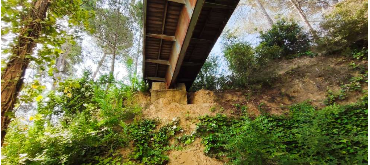
FOTO 3. Vista estrep passera sector talús. Data 17/06/2025.
