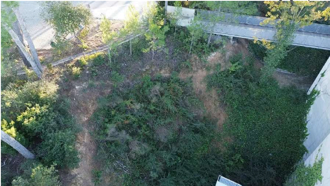
→ FOTO 1. Vista aèria i localització del talús objecte d'actuació.
