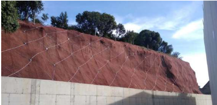
Talús protegit amb manta anti-erosió tipus BIANMAT i malla de triple torsió subjecta amb cables i perns (font: INACCES)
