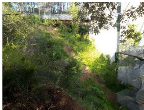
Vista del talús des del costat NE.
