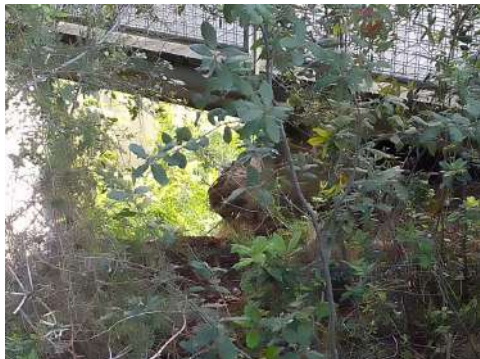
Vista de detall de l'estat de la fonamentació des del costat S.
