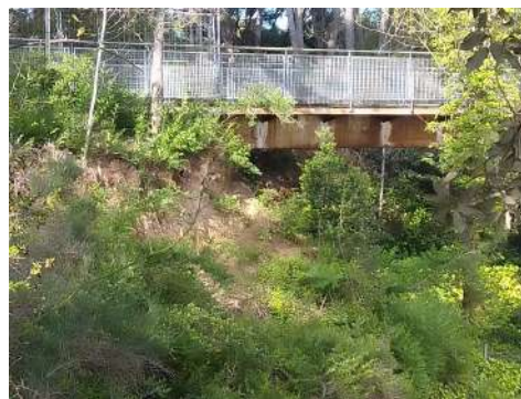
Vista del talús des del costat NE.
