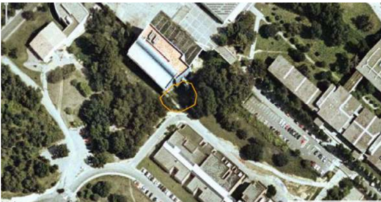
2003, es pot apreciar la passera una vegada construïda
