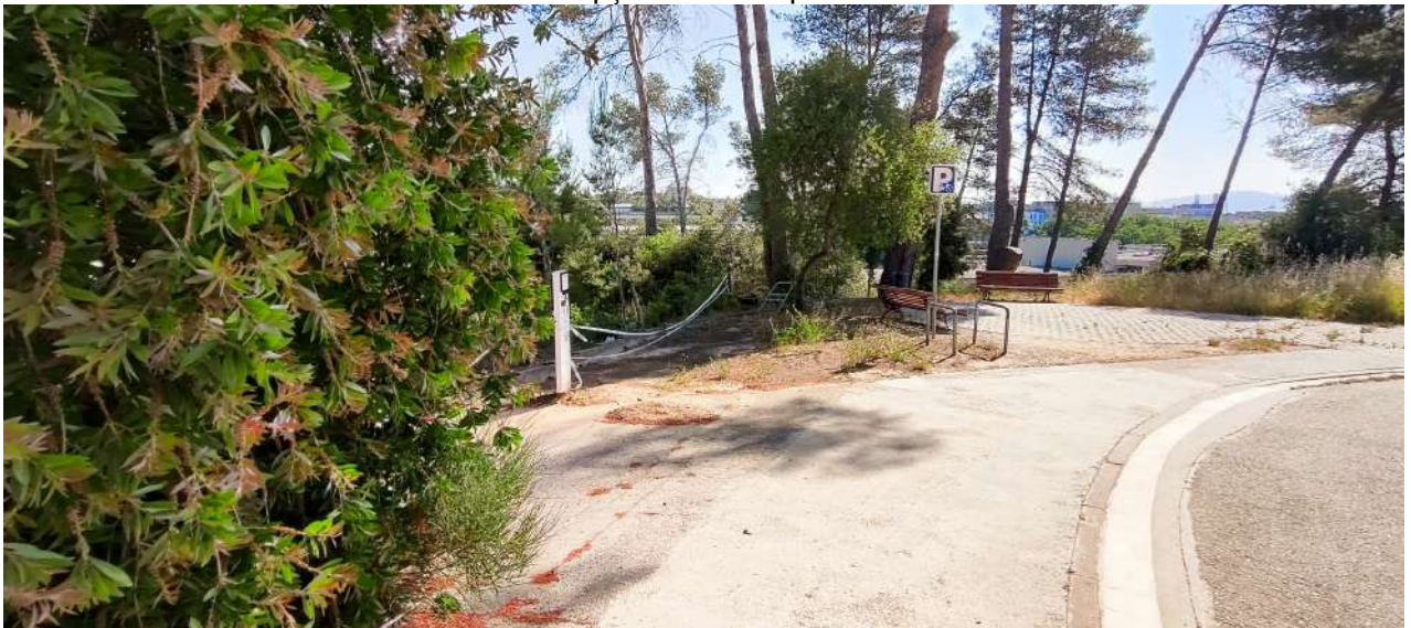
FOTO 7. Sector destinat per a acopi temporal a la capçalera del talús. Data 10/11/2025.
