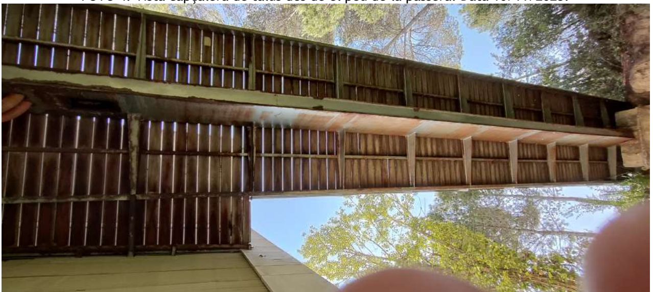
FOTO 5. Vista passera des de peu de talús. Data 10/11/2025.
