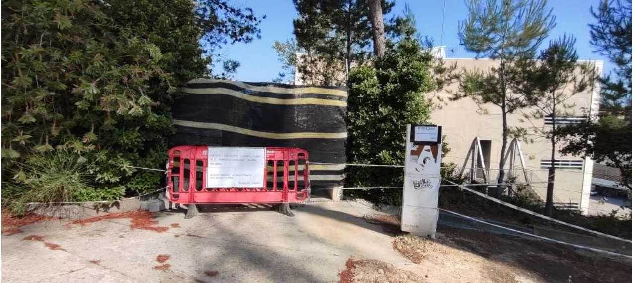
FOTO 6. Via d'accés a capçalera talús i passera. Data 10/11/2025.
