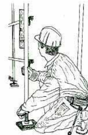
Figura 15. Comprobación de la nivelación vertical
