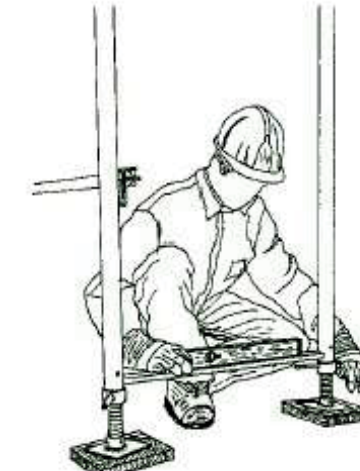
Figura 16. Comprobación de la nivelación horizontal
