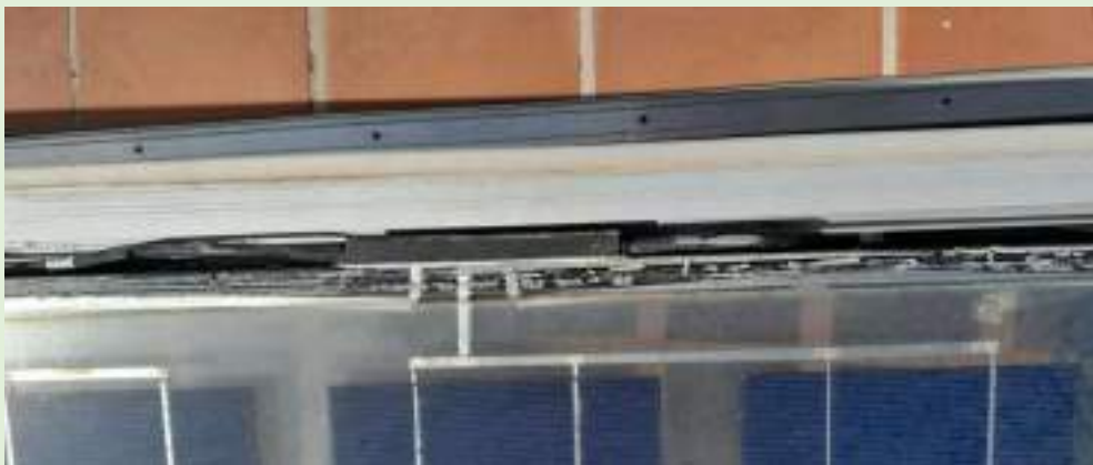
Exemple d'un cas on la caixa de connexions i el cablejat es troba molt ajustat
