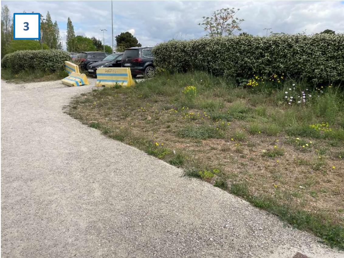
Imatge 3. Entrada lateral on s'instal·laran els prefabricats
