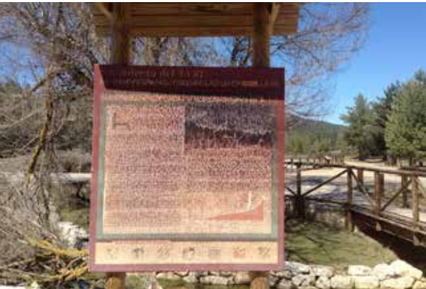
Plafó deteriorat per l'acció solar
