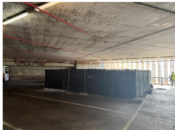
Fotografia 1 Zona de ubicacions del CD1
