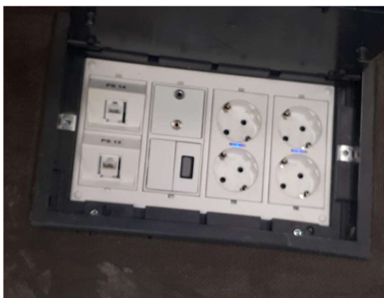
Fotografia de caixa a la tarima existent, per a connectar les dues taules T3
