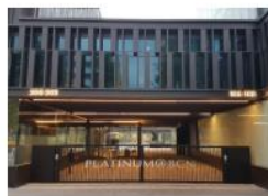
Funcionament edifici Platinum@BCN
