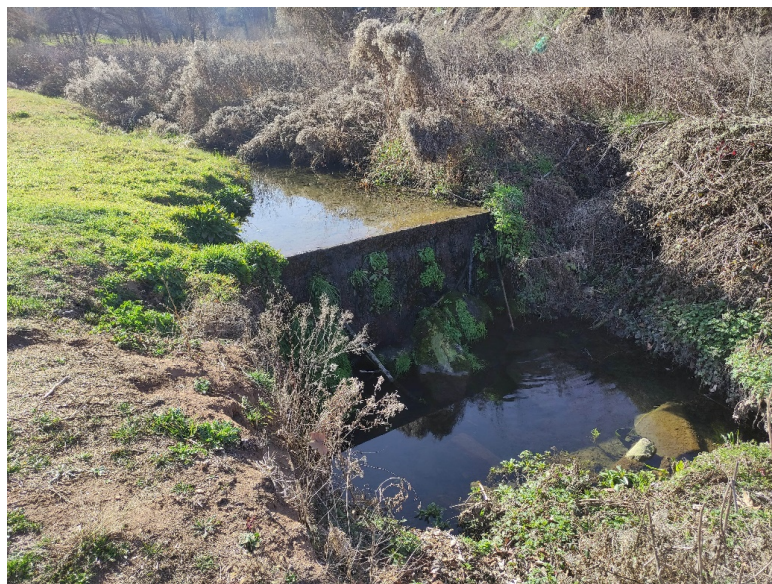
Figura 8 Resclosa creant un ressalt de quasi 2m que interromp la continuïtat de l'aigua. (visió aigües amunt)
