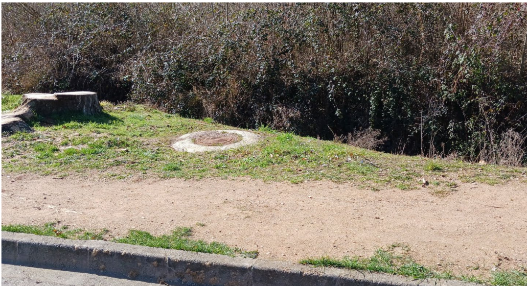
Figura 17 Registre de sanejament i soca de pollancre en el límit de l'actuació
