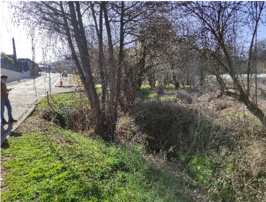
Figura 4 Tram de riera proper al carrer i nucli de verns
