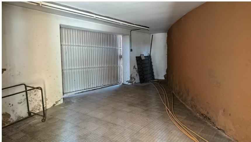
Interior sala d'autòpsies ZONA 2 Antiga entrada vehicles
