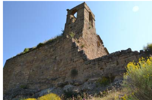
FOTO 4.- Església façana lateral Oest
