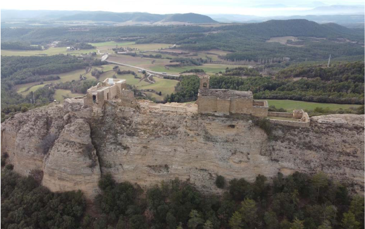
FOTOGRAFIA GENERAL NORD-EST
