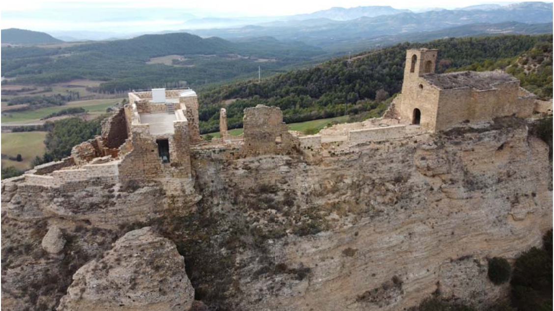
Vista DRON de les obres realitzades
