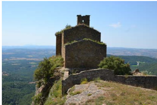
FOTO 1.- General vista cap a Sud
