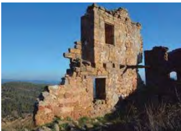
Fig. 11. Tancament de llevant de l'àmbit 11.
