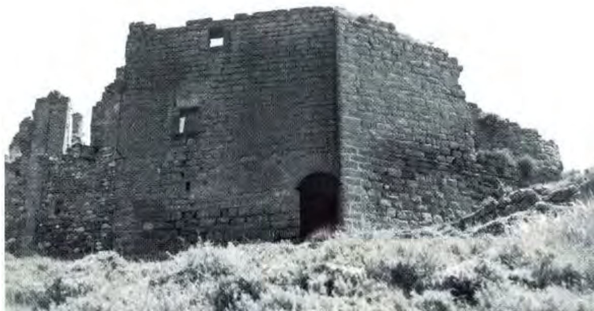
Fig. 3. Façana de ponent del cos 18 del castell. Extreta de Català, 1979:25. La finestra superior avui ja no hi és, i amb ella van caure prop de 7 filades d'aquest mur. precisament en aquest vessant es troben un gran nombre de carreus caiguts.
