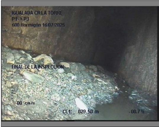
Foto: 2_1_16_16072025_103557103557_A.JPG 29,5m, FINAL DE LA INSPECCION
