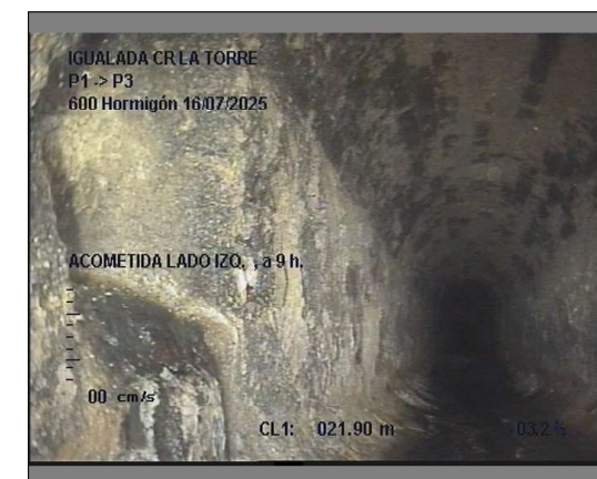
Foto: 2_1_9_16072025_102903102903_A.JPG 22,5m, ACOMETIDA LADO IZQ. , a 9 h.
