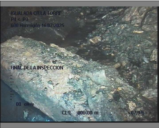
Foto: 5_1_6_16072025_112333112333_A.JPG 3m, FINAL DE LA INSPECCION
