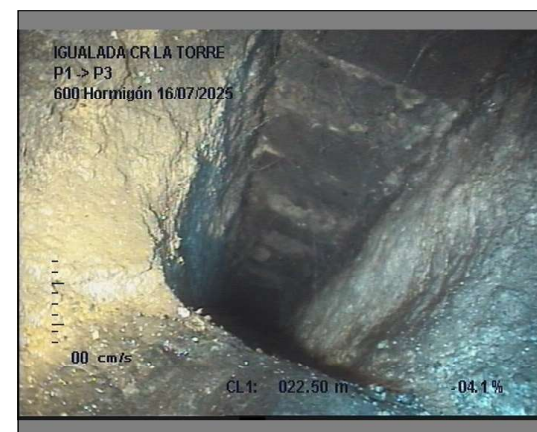
Foto: 2_1_9_16072025_102913102913_B.JPG 22,5m, ACOMETIDA LADO IZQ. , a 9 h.
