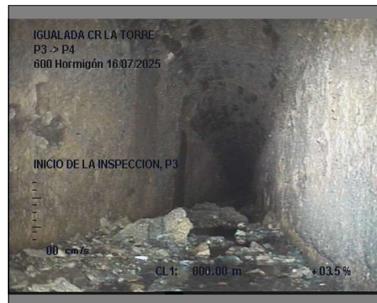
Foto: 3_1_1_16072025_105124105124_A.JPG 0m, INICIO DE LA INSPECCION, P3
