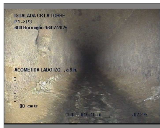
Foto: 2_1_7_16072025_102731102731_A.JPG 15,1m, ACOMETIDA LADO IZQ. , a 9 h.
