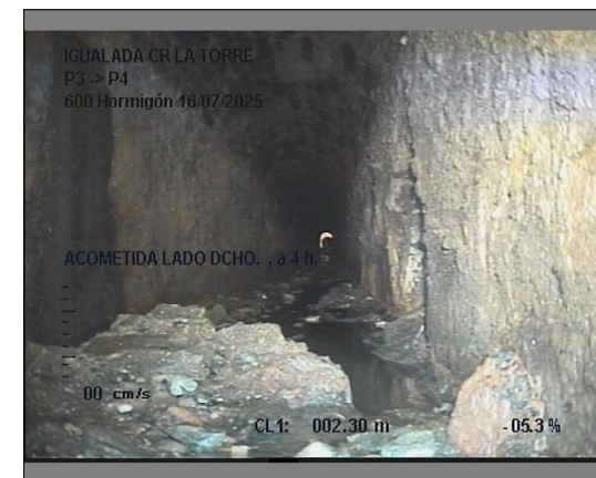
Foto: 3_1_4_16072025_105614105614_A.JPG 2,3m, ACOMETIDA LADO DCHO. , a 4 h.
