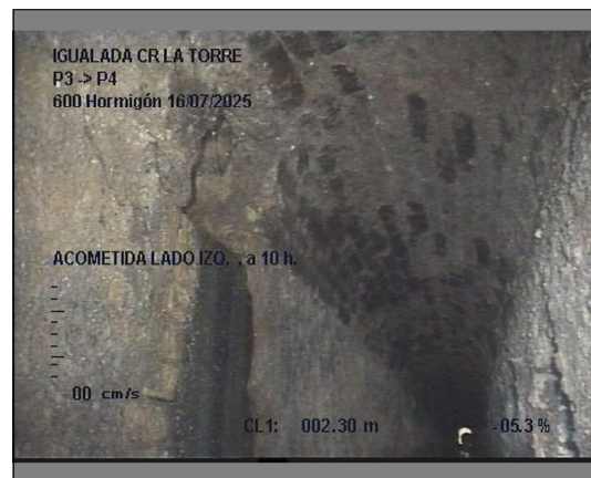
Foto: 3_1_3_16072025_105524105524_A.JPG 2,3m, ACOMETIDA LADO IZQ. , a 10 h.
