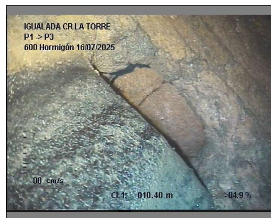
Foto: 2_1_6_16072025_102633102633_B.JPG 10,4m, ACOMETIDA LADO IZQ. , a 11 h.
