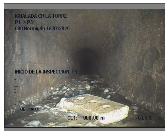
Foto: 2_1_1_16072025_102218102218_A.JPG 0m, INICIO DE LA INSPECCION, P1
