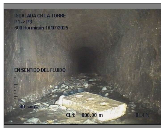
Foto: 2_1_2_16072025_102233102233_A.JPG 0m, EN SENTIDO DEL FLUIDO
