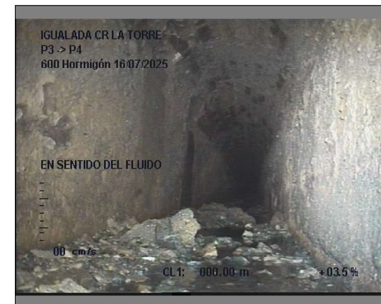
Foto: 3_1_2_16072025_105145105145_A.JPG 0m, EN SENTIDO DEL FLUIDO
