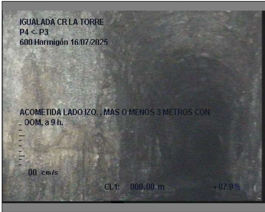
Foto: 5_1_3_16072025_112126112126_A.JPG 3m, ACOMETIDA LADO IZQ. , MAS O MENOS 3 METROS CON ZOOM, a 9 h.
