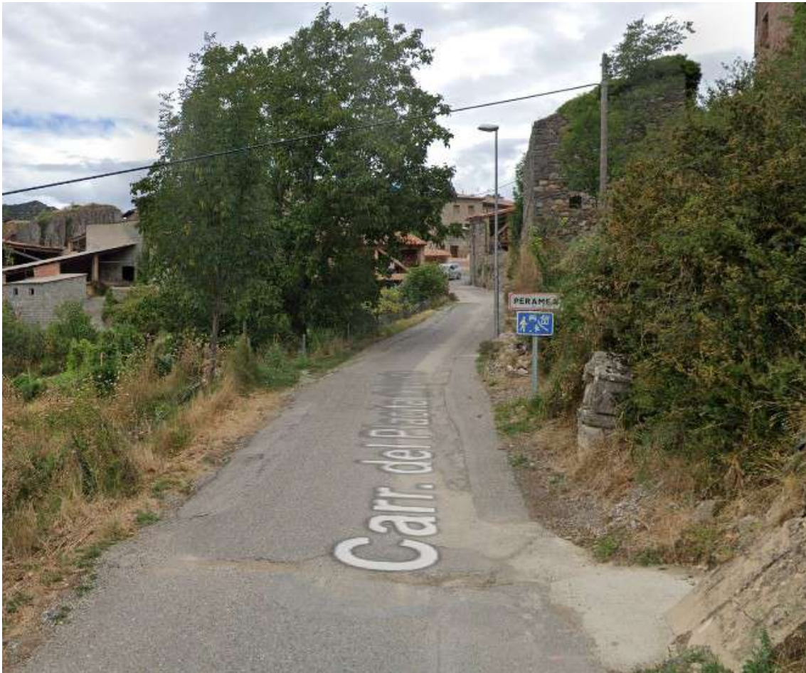
Imatge 9. Paviment a regularitzar
