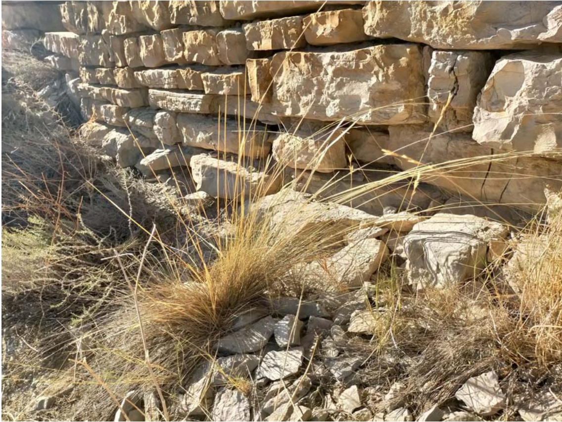
Detall de l'estrat de roca utilitzat com a fonament de la façana sud del colomar
