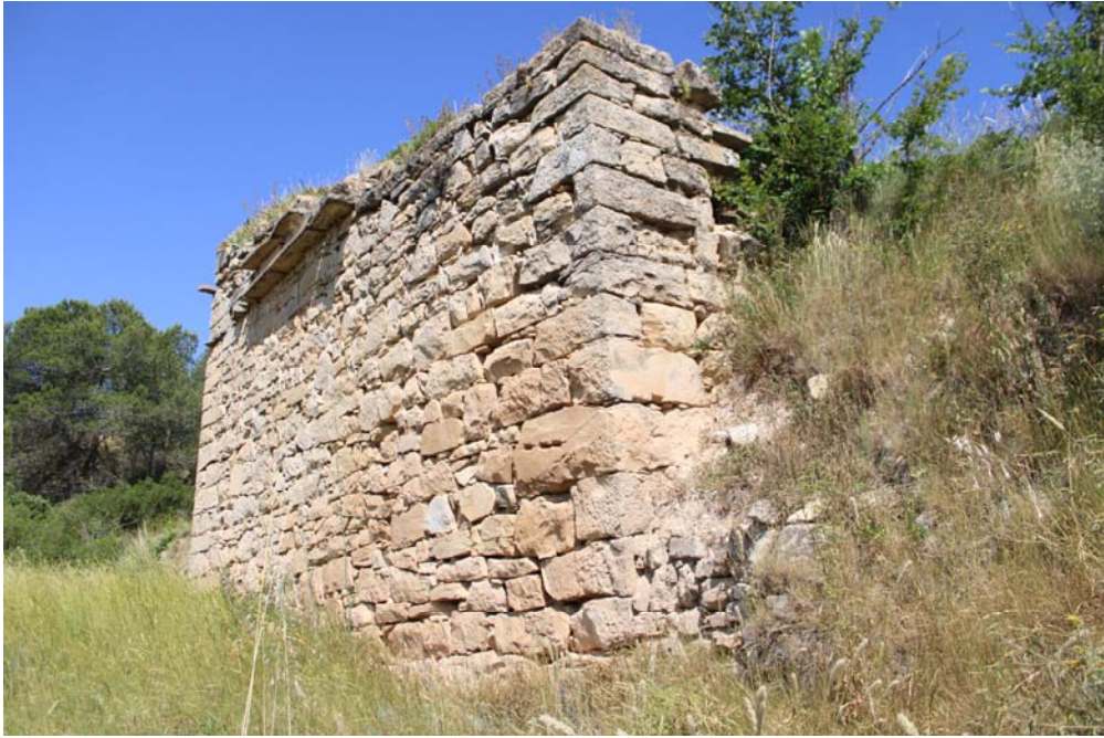
Colomer de Forès: vista de les façanes sud i est. A la façana est s'hi intueix una possible obertura en forma de finestra.
