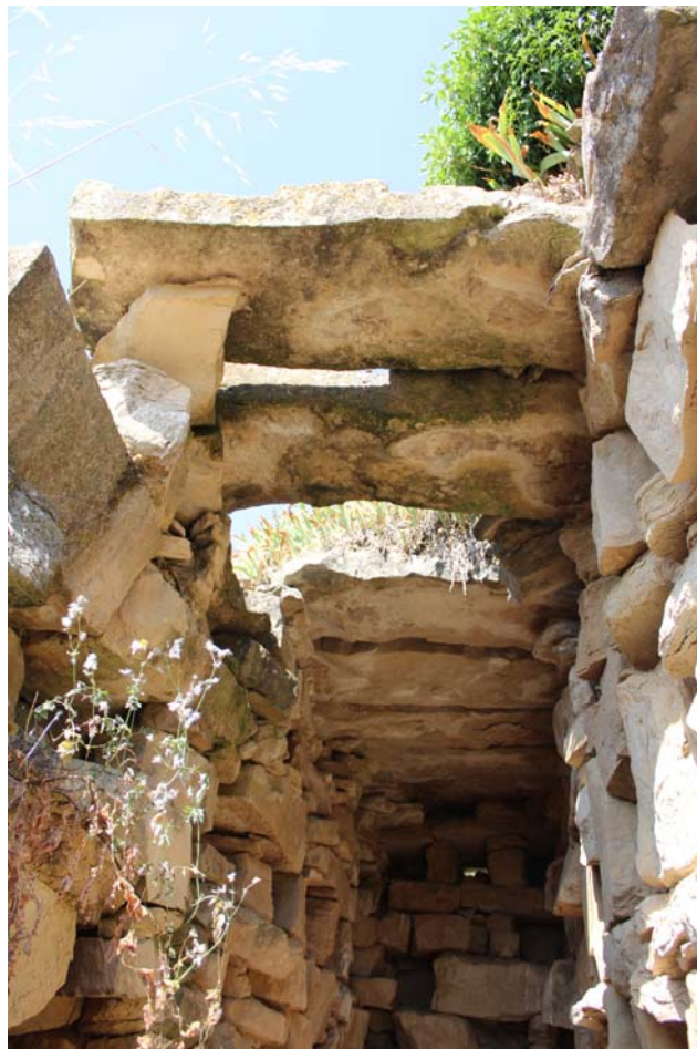
Colomer de Forès: vista de l'interior amb el tram conservat de coberta
