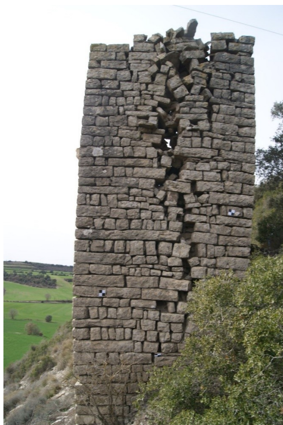
Façanes nord (a dalt) i est (a baix).
