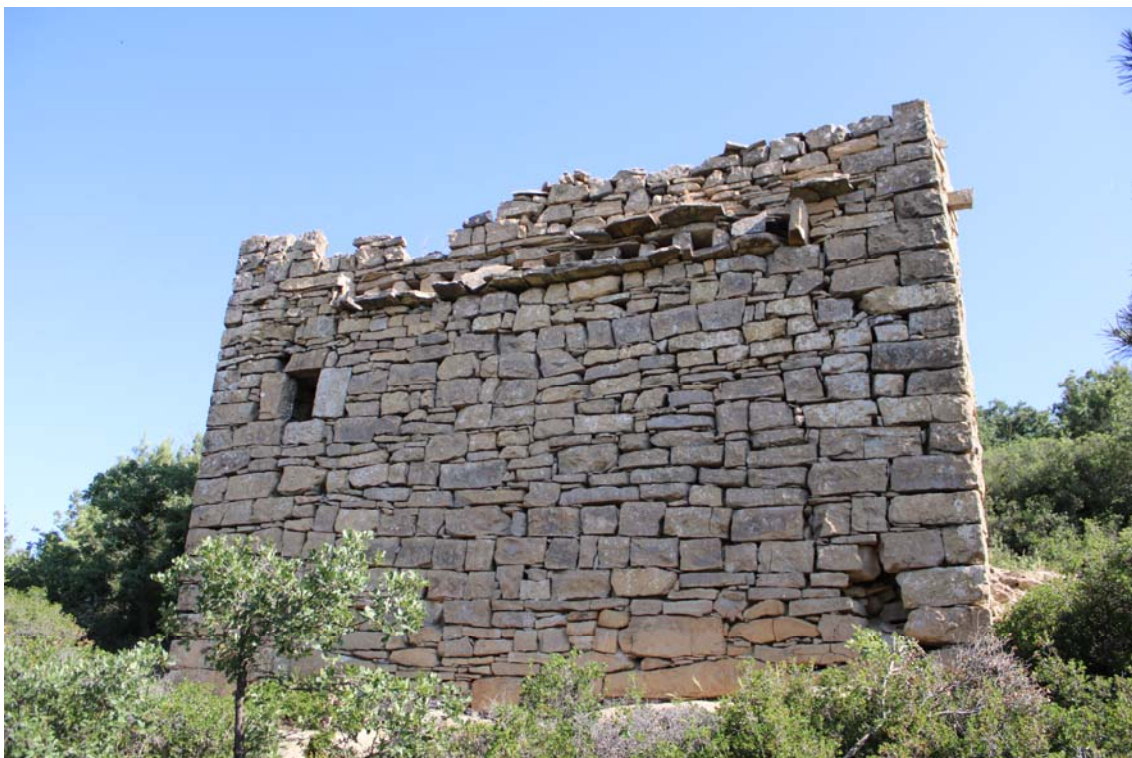
Colomer de Conesa: vista de la façana sud
