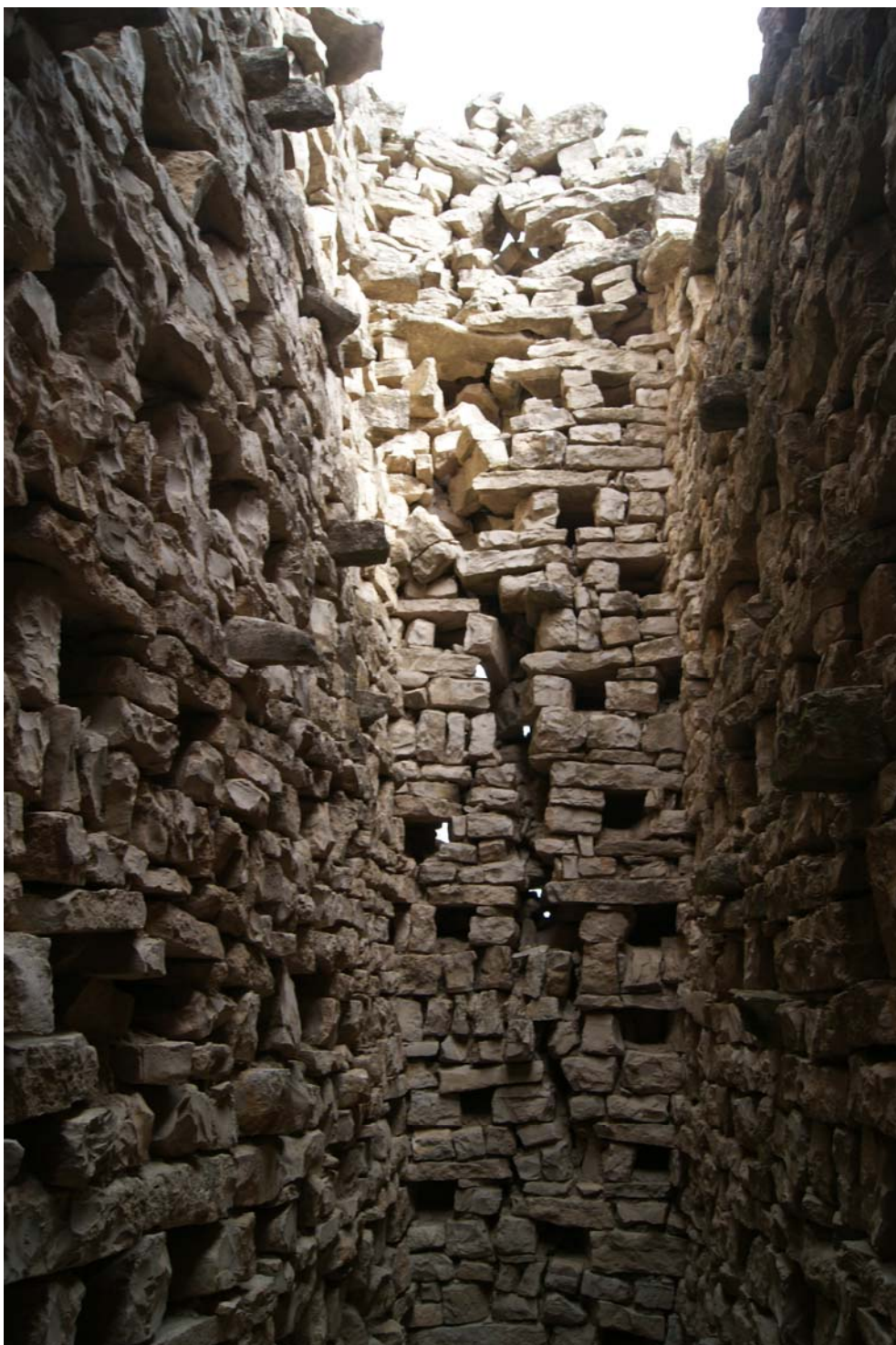
Vista de l'interior de les façanes nord, est i sud i de les fornícules que actuaven de nius.
