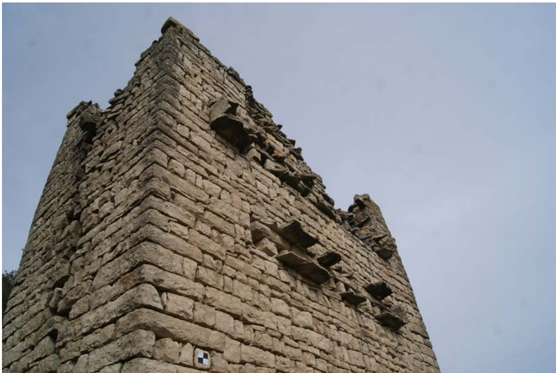
Vista i detall de la façana sud, amb les característiques lleixes d'entrada al colomer.
