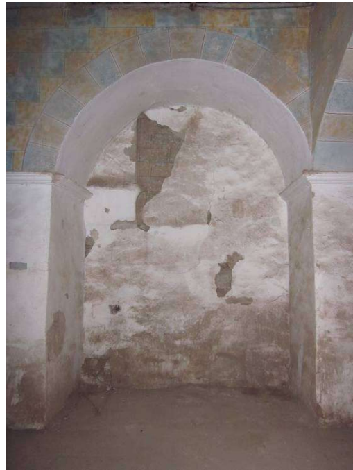
Capelles a recuperar el parament del mur romànic. Restes d'arrebossats amb policromia
