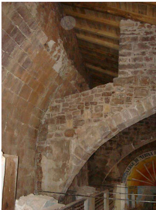
Vista de l'arrancada de la volta romànica i mur del pas de ronda des del nivell del cor
