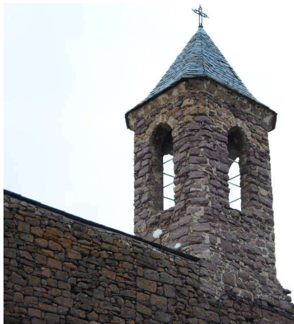
Vistes exteriors del campanar
