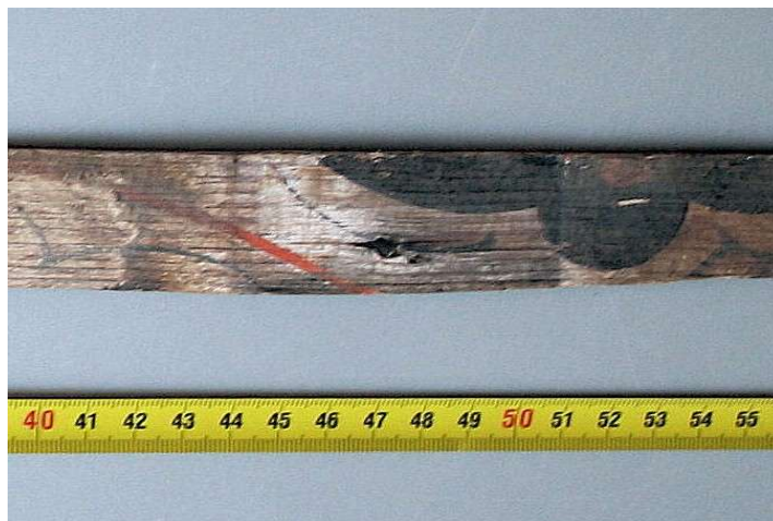
Imatge 6. Traç deixat pel cabiró sobre el que anava clavat el tapajunts
