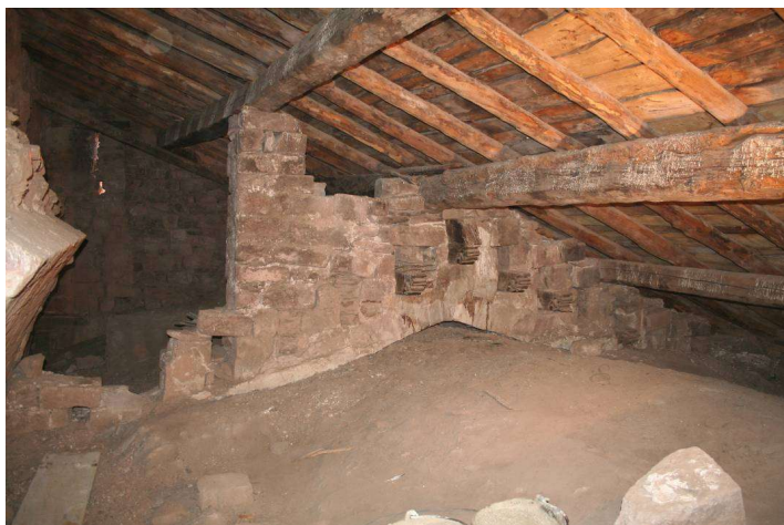
Imatge 1. Superposició diacrònica de les cobertes de l'església. Esquerra restes de la volta romànica. Al centre arc diafragma gòtic amb permòdols del teginat. En primer pla volta de guix barroca.
