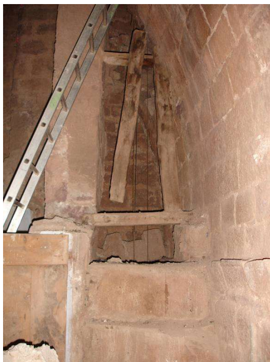
Mur del campanar i arrancada de la volta romànica, al nivell de la planta cor
