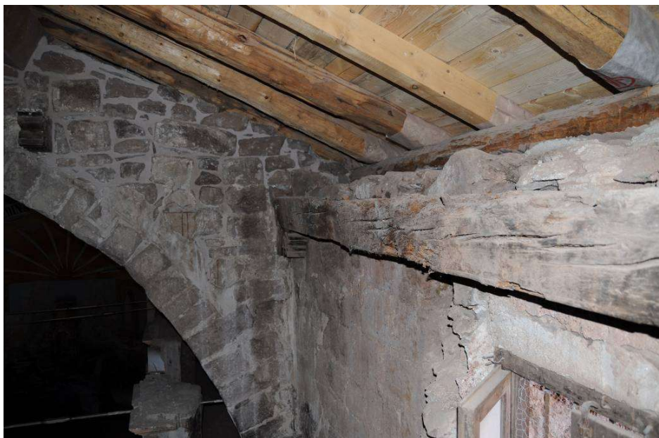
Restes de mènsules i biga de l'estructura d'enteixinat
