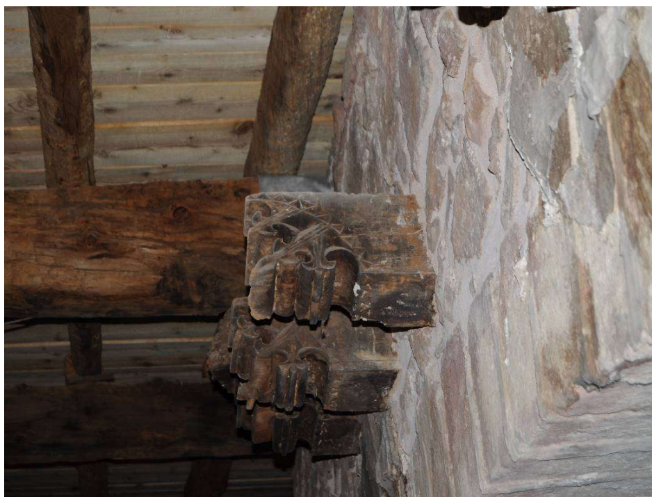
Restes de mènsules de l'estructura d'enteixinat
